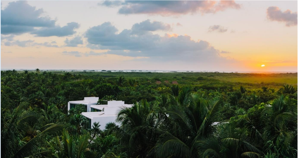
Fachada principal, se observa que se pierde entre la selva, vista desde Tulum.
