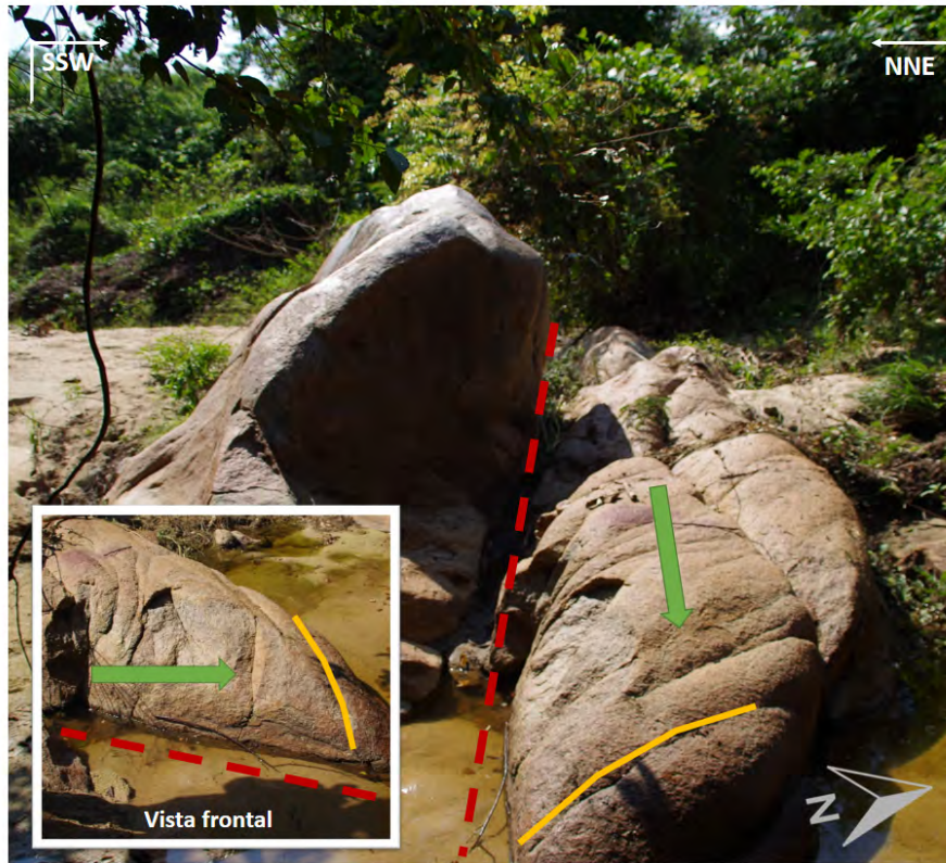
Figura 5.20: Evidencia de estación La Intersección: falla lateral izquierda. La línea roja punteada señala el plano de falla, la línea amarilla el indicador tipo fractura riedel (o cuña ) y la flecha verde indican el sentido del movimiento del bloque ausente. Octubre del 2019.
