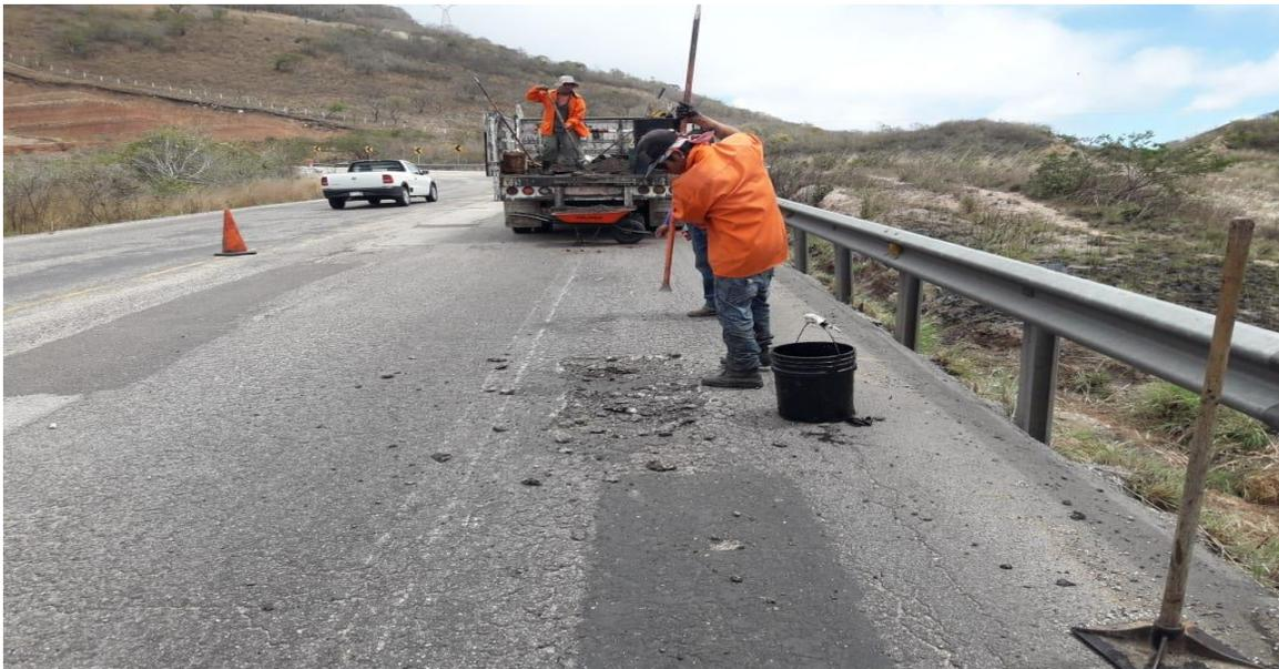
**Figura 4.44** Retiro de carpeta asfáltica y base hidráulica. Crédito: C. Richard Robles Morales
