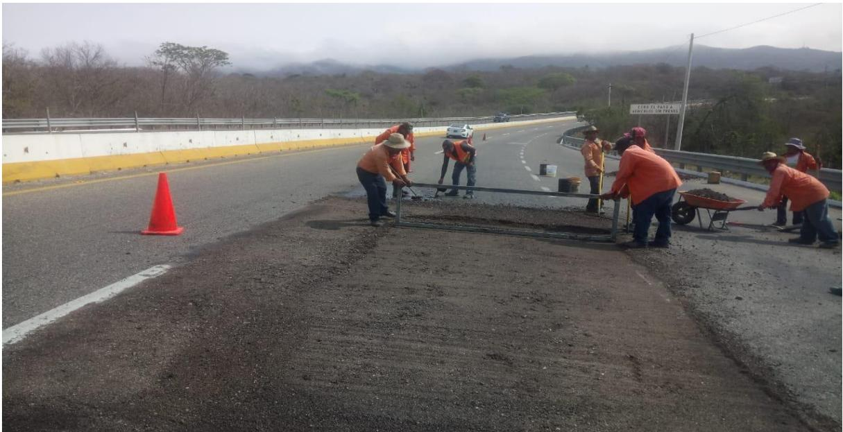
Figura 4.48 Colocación de material asfáltico para la renivelación de la zona asentada. Crédito: C. Richard Robles Morales
