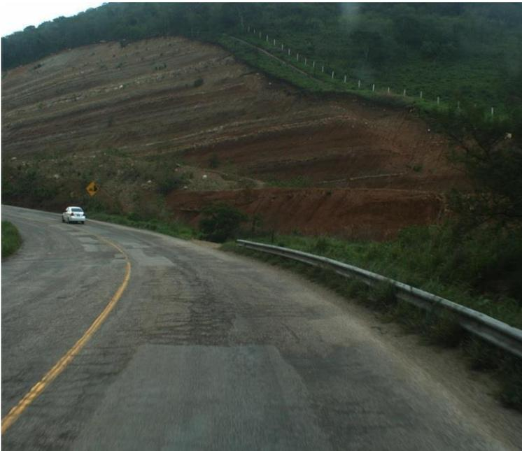
**Fig. 4.7** Se observa calavero y agrietamiento de piel de cocodrilo Km. 6+050 creditos: U.G.S.T.Sct.Tuxtla
