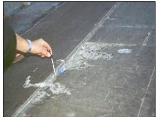
**Figura. 2.17. Deformación por hundimiento**
