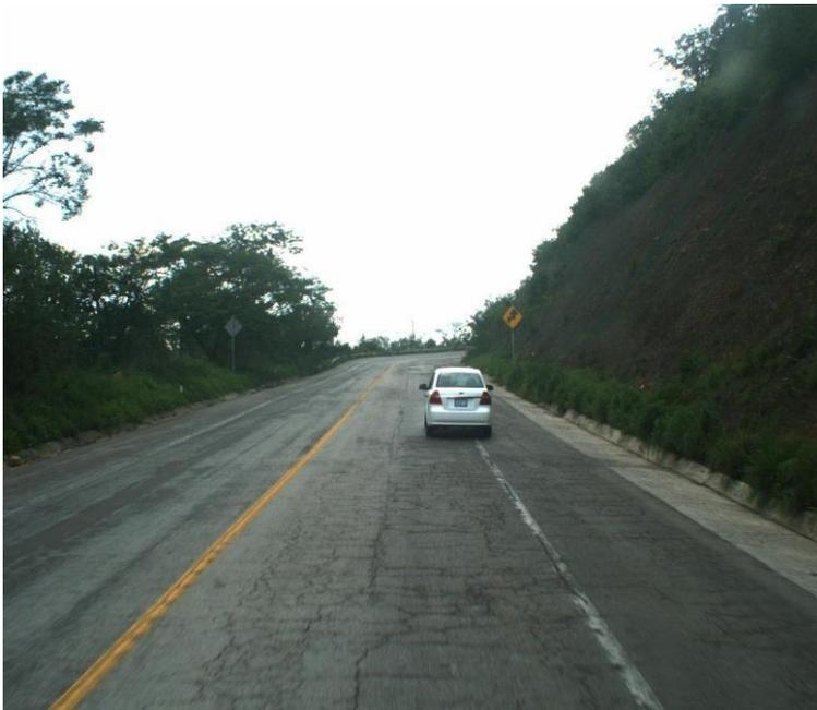
**Fig. 4.15** Se observa agrietamiento de piel de cocodrilo, longitudinal y desprendimiento de agregado finos Km. 7+480 creditos: U.G.S.T.Sct.Tuxtla
