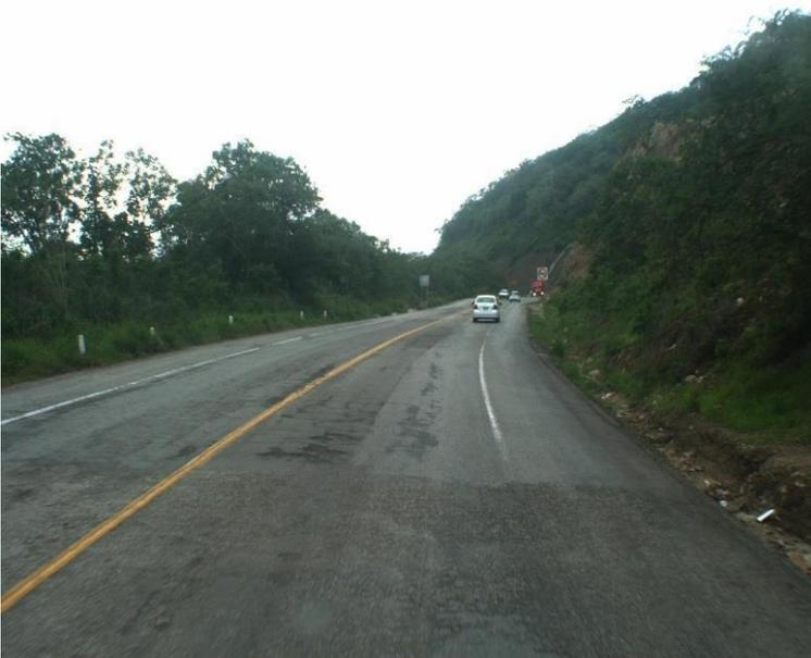
**Fig. 4.9** Se observa desprendimiento de agregados finos y calavereo Km 6+560 creditos:
