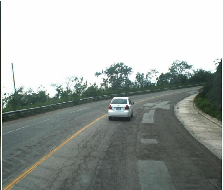
**Fig. 4.16** Se observa agrietamiento de piel de cocodrilo, longitudinal y desprendimiento de agregado finos, baches corregidos Km. 7+500
