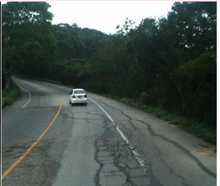
**Fig. 4.24** Se observa agrietamiento longitudinal, calavereo y desprendimiento de la sobre carpeta Km. 8+220 creditos: U.G.S.T.Sct.Tuxtla
