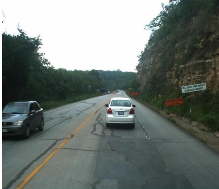
**Fig. 4.21** Se observa agrietamiento longitudinal y transversal Km 8+050 creditos: U.G.S.T.Sct.Tuxtla
