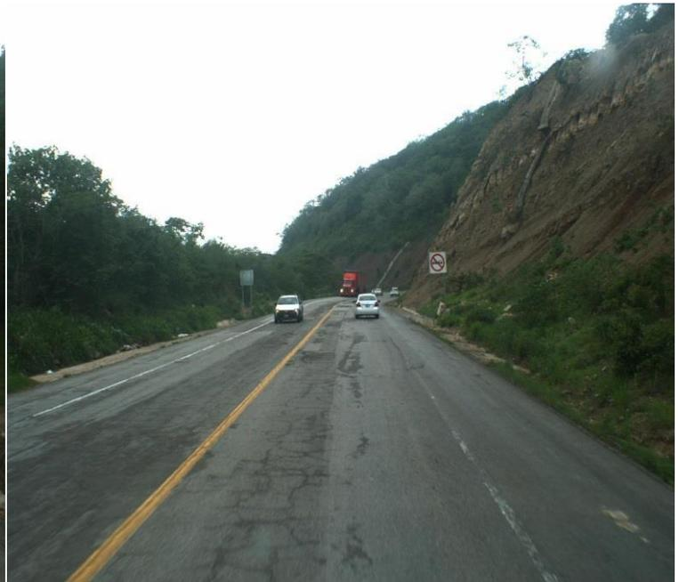
**Fig. 4.10** Se observa agrietamiento de piel de cocodrilo y desprendimiento de agregados fino Km. 6+690 creditos: Unidad Gral. Servicios Tecnicos.Sct.Tuxtla
