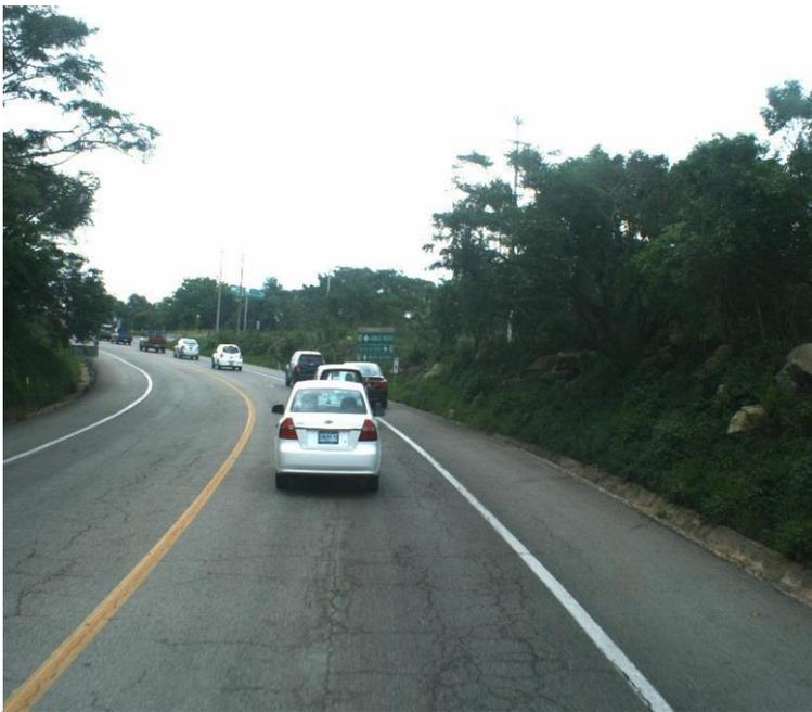
**Fig. 4.27** Se observa agrietamiento longitudinal y piel de cocodrilo Km. 9+200 creditos: U.G.S.T.Sct.Tuxtla
