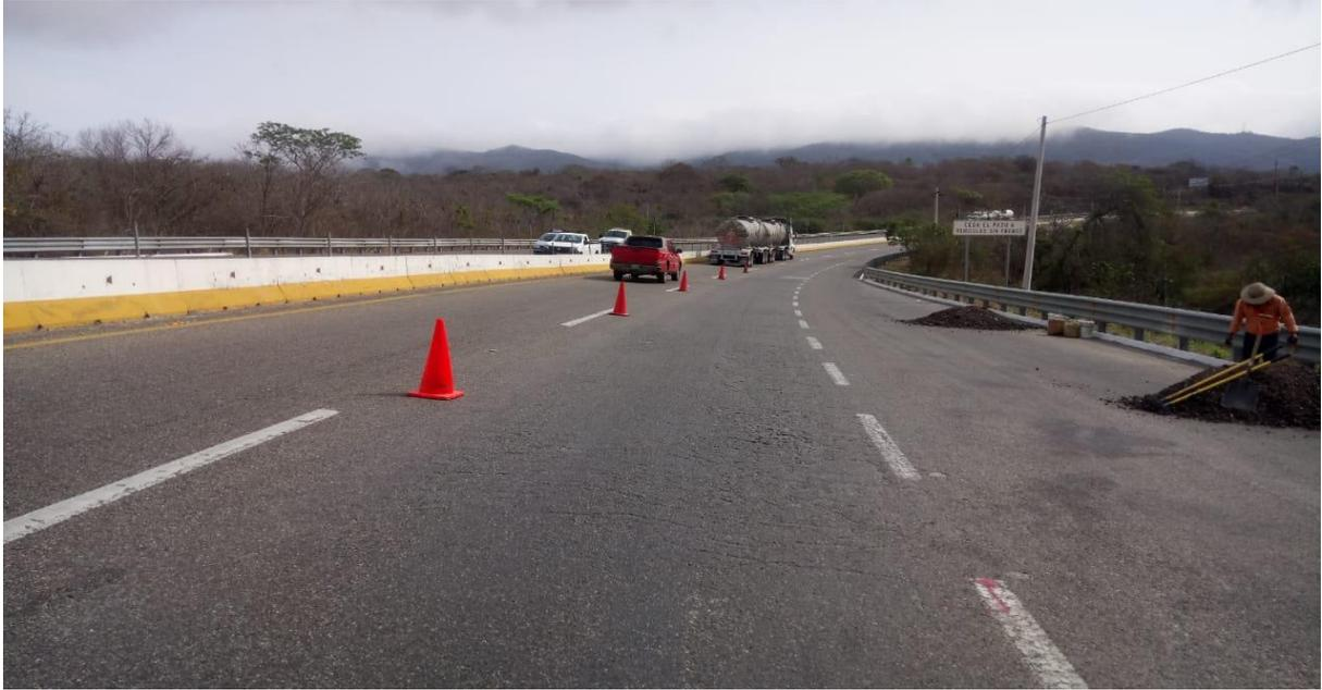
Figura 4.47 Colocación de señalamiento y dispositivo para protección de obras. Crédito: C. Richard Robles Morales
