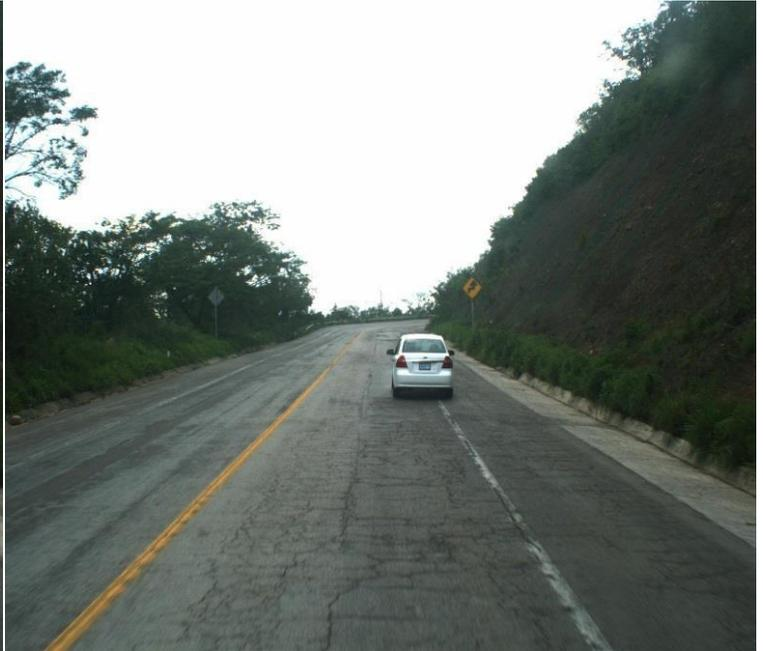
**Fig. 4.14** Se observa agrietamiento de piel de cocodrilo, longitudinal y desprendimiento de agregado finos Km. 7+465 creditos: U.G.S.T.Sct.Tuxtla
