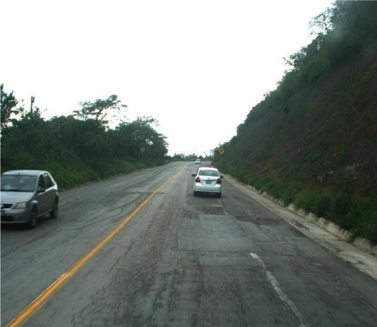
**Fig. 4.13** Se observa agrietamiento de piel de cocodrilo Km 7+440 creditos: Unidad Gral. Servicios Tecnicos.Sct.Tuxtla
