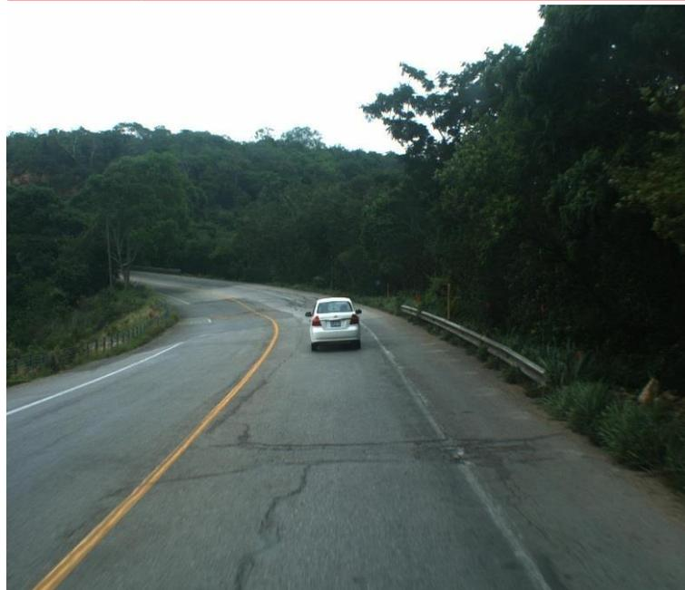
**Fig. 4.23** Se observa agrietamiento longitudinal y transversal Km. 8+160 creditos: U.G.S.T.Sct.Tuxtla
