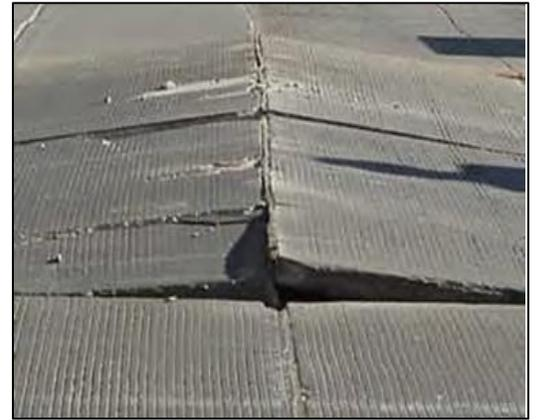
**Figura. 2.16. Levantamiento de losas**
