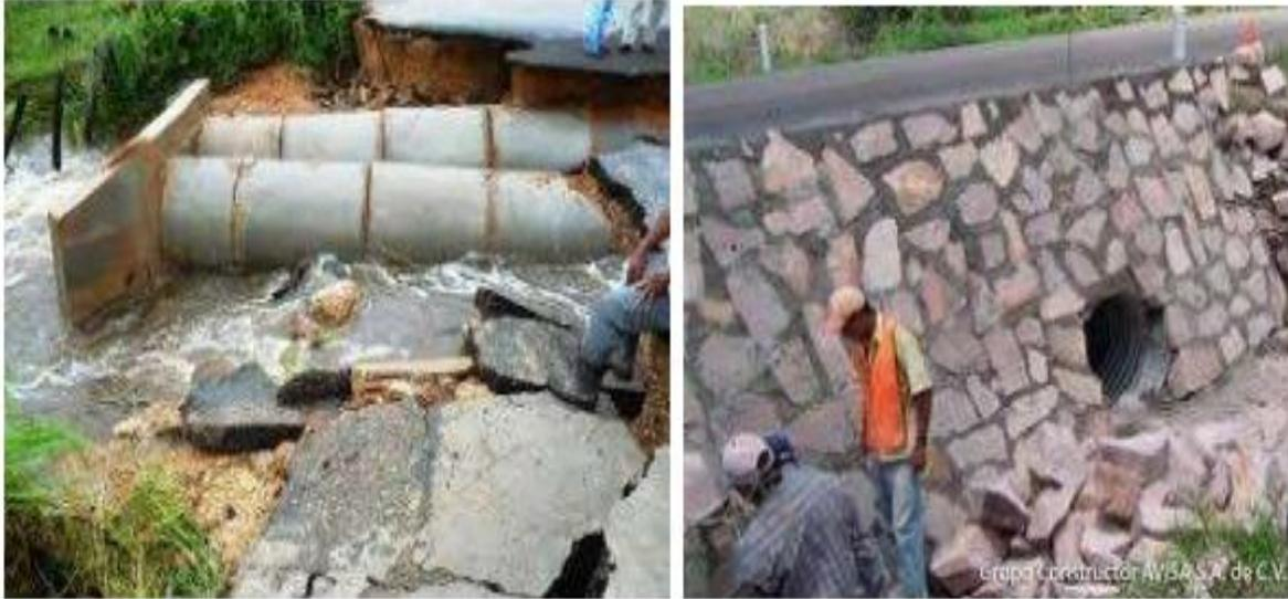
Fig .2.26. reparación de alcantarilla. Créditos: DGST.
