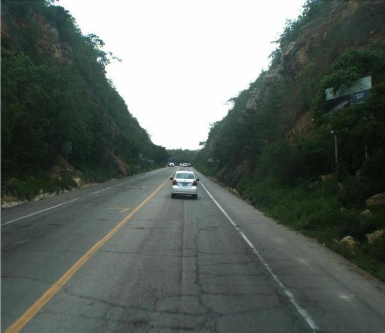
**Fig. 4.25** Se observa agrietamiento de poligonal y transversal Km 8+280 creditos: U.G.S.T.Sct.Tuxtla
