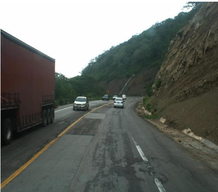
**Fig. 4.11** Se observa baches corregidos y exudación de asfalto Km. 6+750 creditos: U.G.S.T.Sct.Tuxtla
