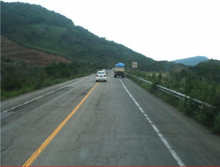
**Fig. 4.5** Se observa calavero y agrietamiento poligonal Km 5+600 creditos: Unidad Gral. Servicios
