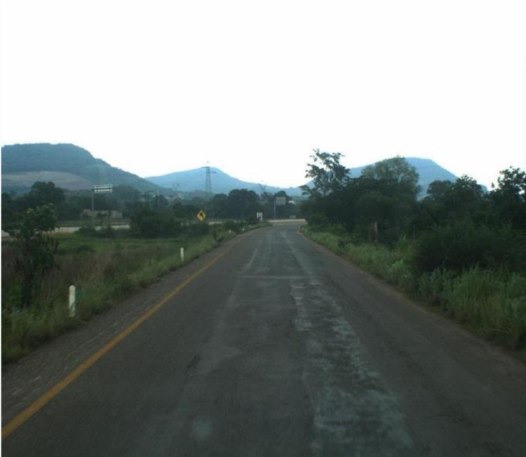
**Fig. 4.1** Se observa desprendimiento de la sobre carpeta km. 0+000 al Km 4+560 creditos:
