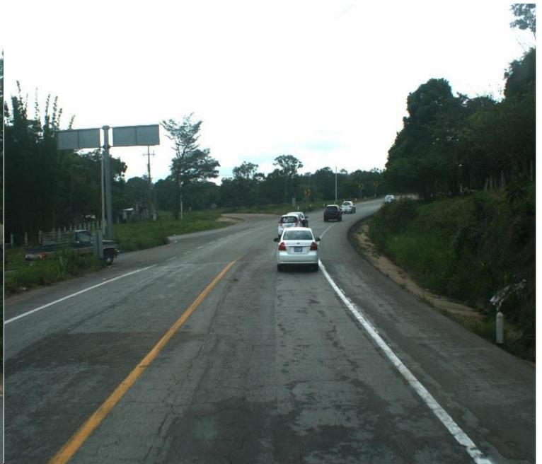
**Fig. 4.28** Se observa agrietamiento longitudinal y piel de cocodrilo y exudación de asfalto Km. 9+500
