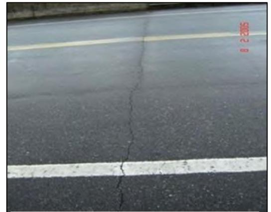
**Figura. 2.2. Agrietamiento transversal**
