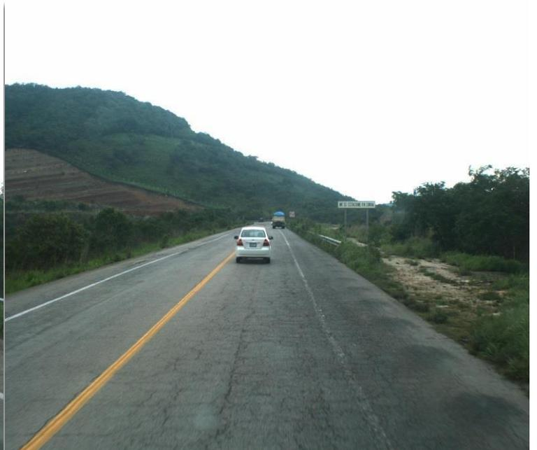
**Fig. 4.4** Se observa agrietamiento piel de cocodrilo Km. 5+420 creditos: Unidad Gal. Servicios
