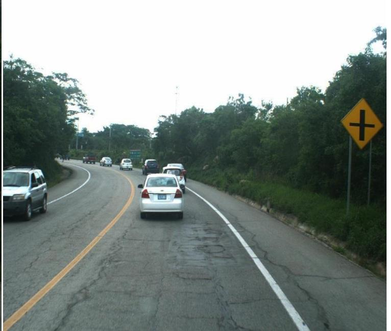
**Fig. 4.26** Se aprecian agrietamiento longitudinal y poligonal Km. 9+100 creditos: U.G.S.T.Sct.Tuxtla
