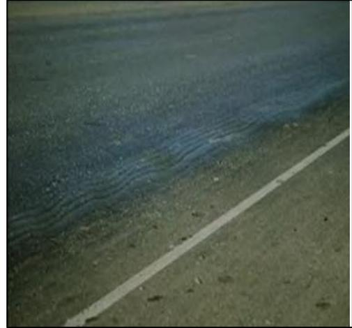
**Figura. 2.6. Deformación transversal**
