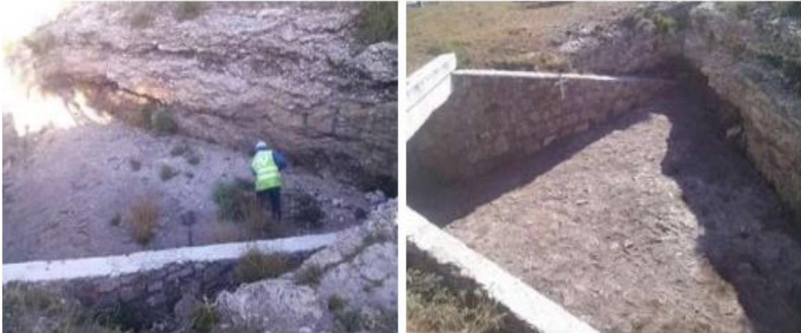
Fig. 2.25. limpieza de entrada y salida de canales (DGST, 2014)
