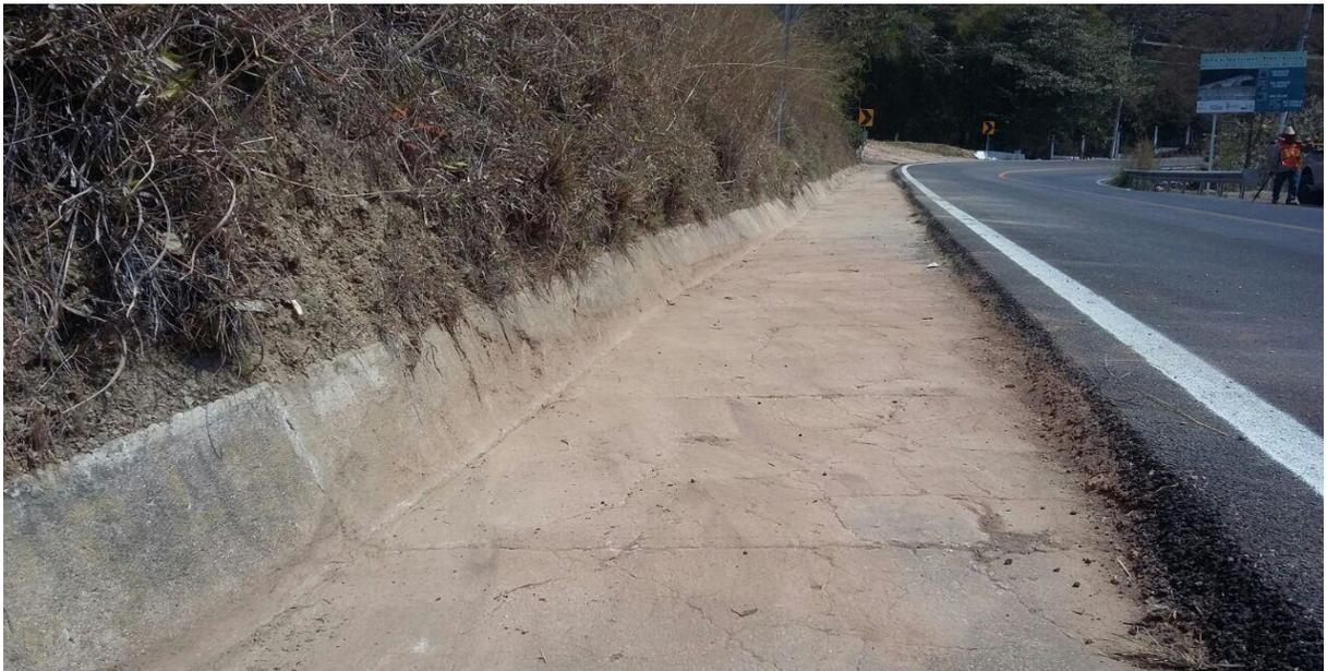
**Figura 4.34** Condición posterior a los trabajos de remoción de derrumbes. Crédito: C. Richard Robles Morales
