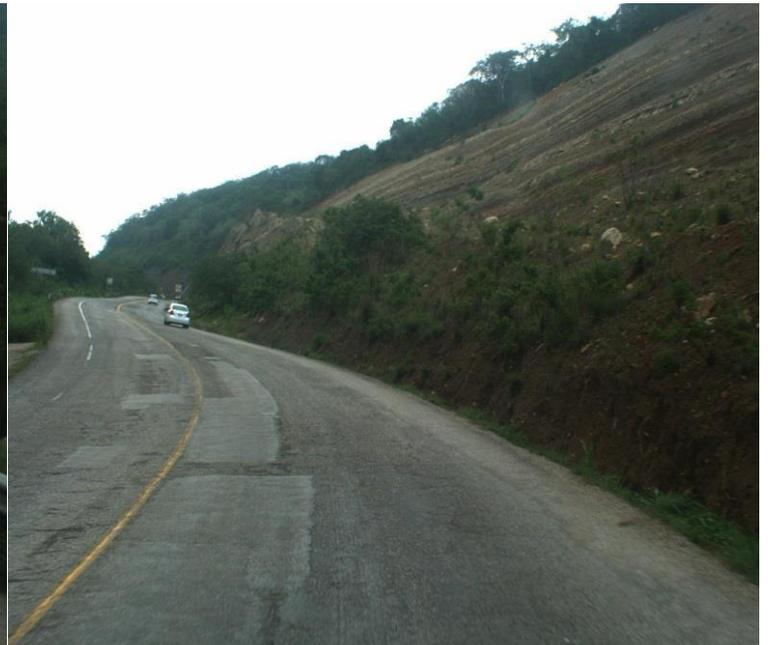
**Fig. 4.8** Se observa calavero y baches mal renivelado Km. 6+220 creditos: Unidad Gral. Servicios
