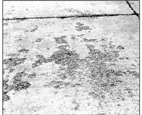
**Figura. 2.19. Descascaramientos y Escamaduras** crédito: dirección general servicios técnico. SCT.
