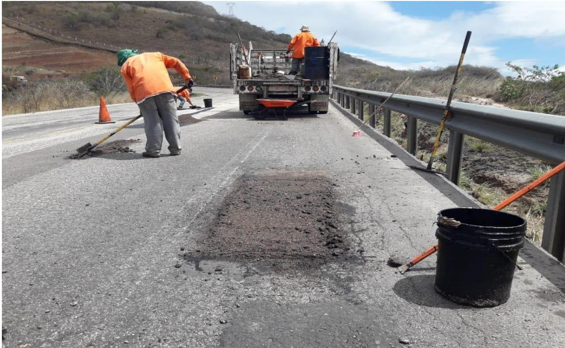
**Figura 4.45** Colocación de material asfáltico como parte de los trabajos de bacheo profundo asilado. Crédito: C. Richard Robles Morales
