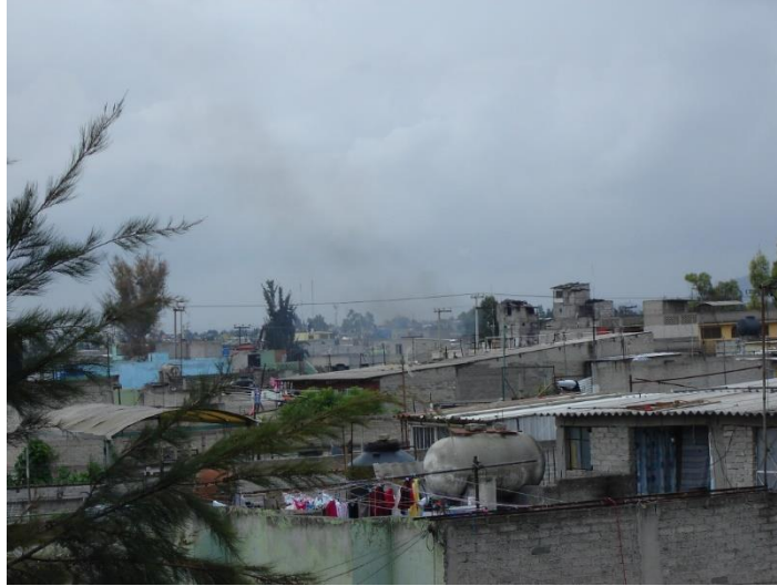
Figura 5. Estación de monitoreo atmosférico SAG, Ecatepec.
