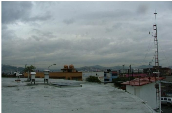
Figura 6. Estación de monitoreo atmosférico Tlalnepantla.
