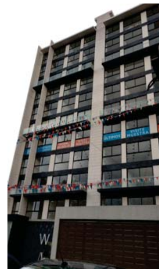
Figura 14. Edificios de más de 6 niveles ya son una realidad en Oxtopulco. FOTO tomada por Erick Velázquez.
