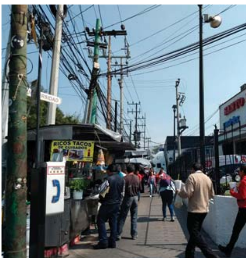
Figura 73. Las calles están llenas de cables, postes y ambulantes que hacen difícil el paso al peatón. FOTO tomada por Erick Velázquez
