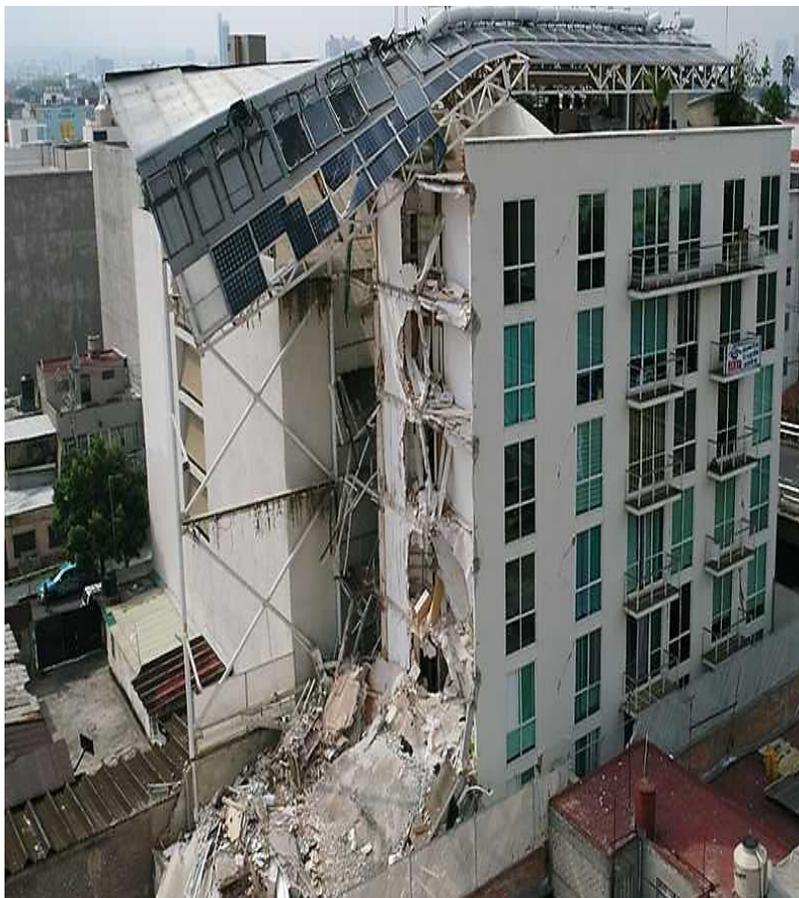
*Figura 3.11.  $DS_5$  - Edificio BJU66\_2017 colapsó durante el sismo (2017) (imagen obtenida de <https://bit.ly/39xBsXq>)*
