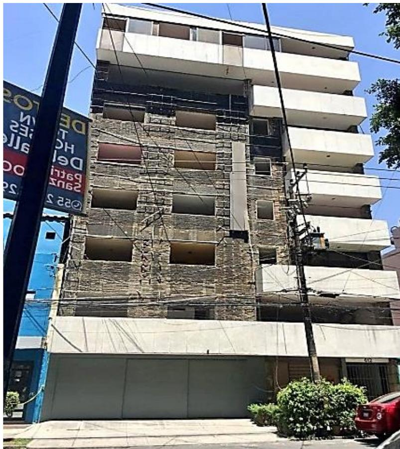
Figura 3.10.  $DS_4$  - BJU34\_2017 tuvo daños tan severos que ameritó su demolición (imagen obtenida de <https://bit.ly/2Nb9AP9>)
