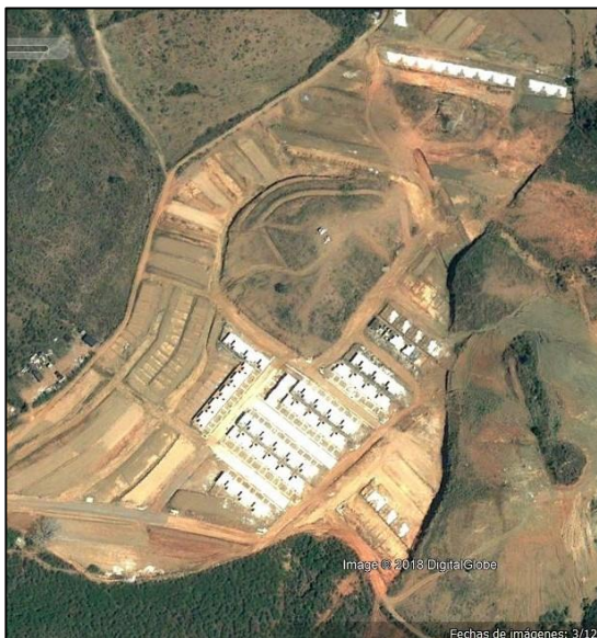
Imagen 6: Fraccionamiento San Antonio al momento de su construcción.
