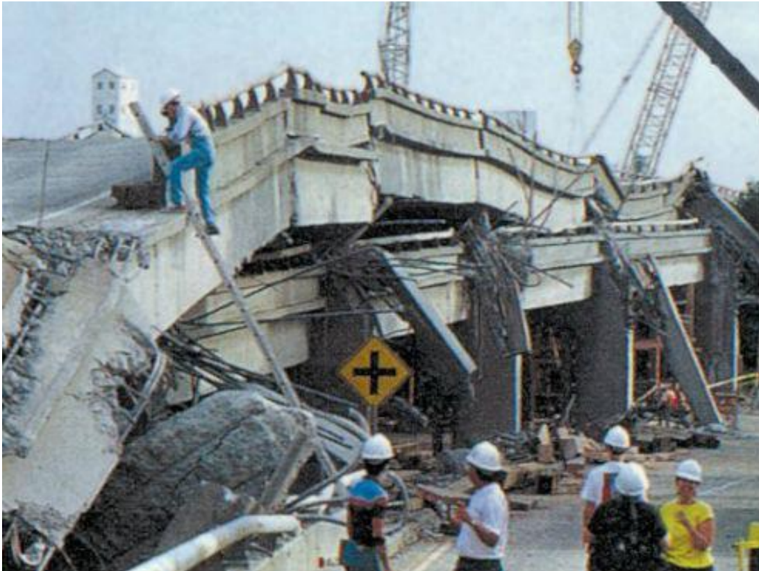
Fig. 1 Fallas en puente causado por el sismo de Loma Prieta 1989 (Avalos, 2017)
