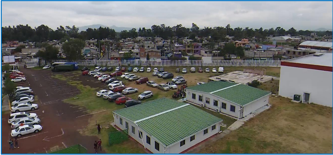
Figura 1. 7. Estacionamientos del ITTII.
