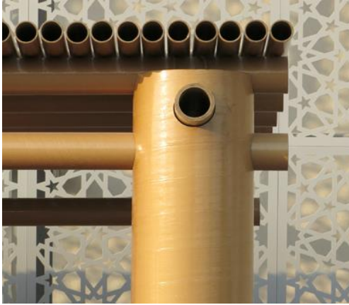
Columna y vigas de cartón
