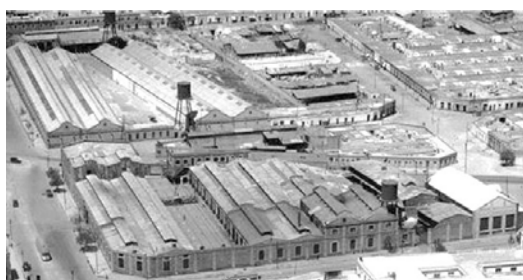
Imagen 278: Estación y Talleres Indianilla (sección foto) panorámica al norte de la sección 2 y 3 de las instalaciones y galerones características de la zona Indianilla – Hidalgo 1887 -1950.
