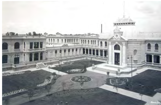
Imagen 129: Nuevo Hospicio de Niños Expósitos Vista hacia el interior de los patios de las crujías del conjunto. Centro de información fotográfica Facultad de Arquitectura UNAM 2019. Con fines académicos.
