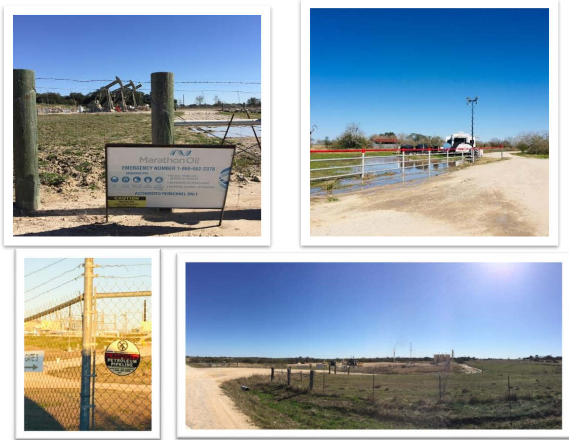
Ilustración 4. Delimitación de terrenos, caminos de acceso y tránsito de camiones
