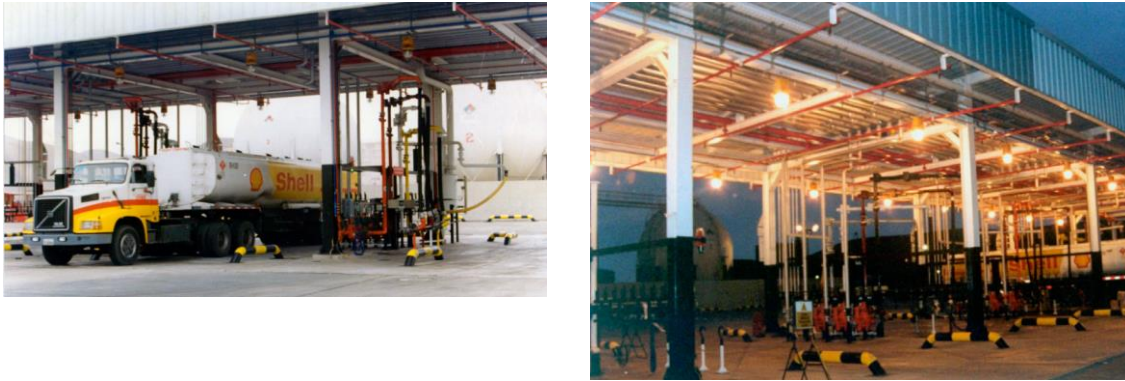
Figura 6.9 Zonas de carga de camiones. Tomada de https://www.montrel.es/es/proyectos/refineriarepsolpampilla/
