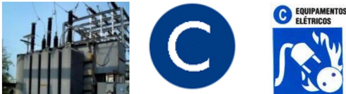
Figura 1.7 Fuego clase C (Tomada de Curso de Nociones básicas de prevención de conato de incendio, Escuela Nacional de Protección Civil, marzo de 2015).
