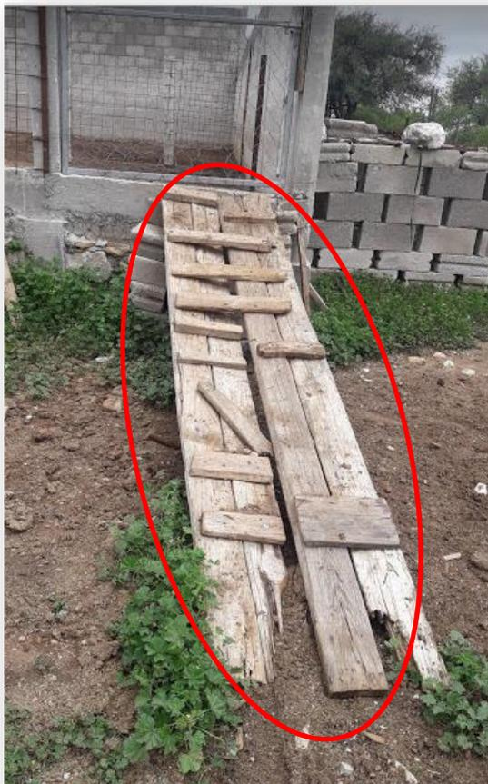
En esta UPP colocan dos tablas sobre expuestas en una base de ladrillos mal colocados en la entrada para subir y entrar al corral. Además se observa que pusieron unas tablitas en escalones que no están bien clavadas o que no se les dio mantenimiento. Esta falla es una de las más peligrosas ya que pone en riesgo al productor, los trabajadores y los animales.
