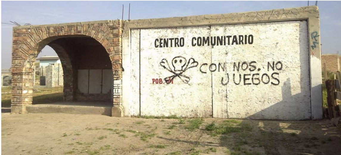
Foto 13. Amenaza en pared del Centro Comunitario
