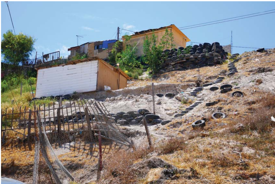
Foto 12. Cimientos de las viviendas del poblado Maclovio Rojas
