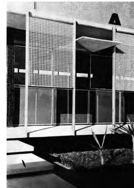
Fig. 73 1961 Edificio de oficinas, Fábrica de Envases “Tetramex S .A.”, Progreso 6 esq. Central, Alce Blanco, Naucalpan de Juárez, Estado de México, México (remodelado) Arq.. Fernando Bárbara Zetina con Félix Candela y Francisco Treviño
