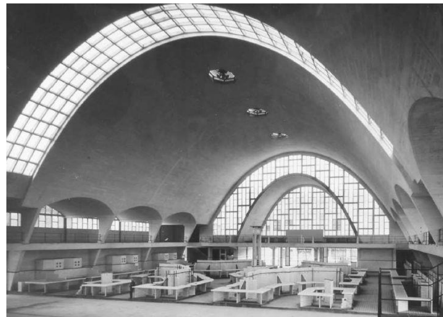
Fig. 145 Eugène Freyssinet Les Halles du Boulingrin Reims, France 1929
