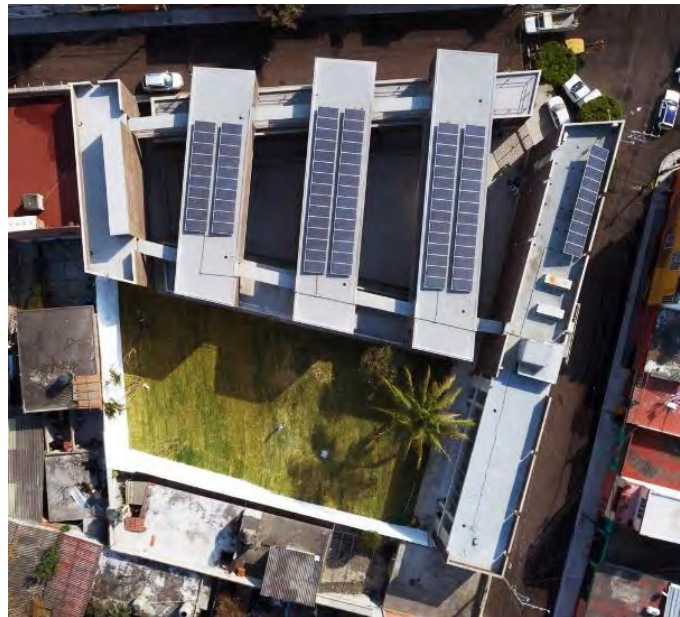
Fig. 239 CDCC, vista aérea (azoteas)
