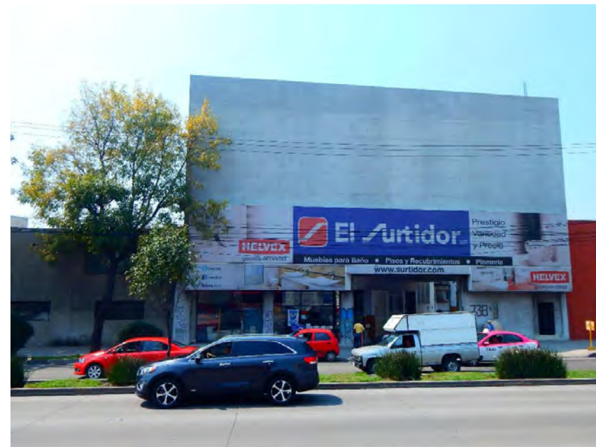
Fig. 203 Outlet de Materiales sobre Av. Vallejo
