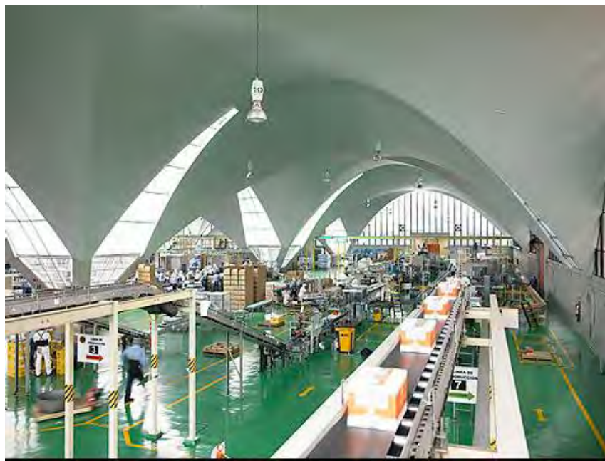
Fig. 144 Interior edificio de embotellado Felix Candela 1960
