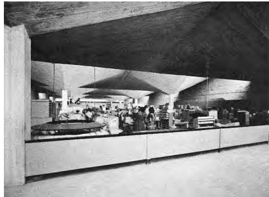
Fig. 70 1956 Vista interior de la planta superior, fábrica Remington Rand. Colonia Santo Tomás, Azcapotzalco, Ciudad de México Arq.. José Luis Córdoba y Félix Candela
