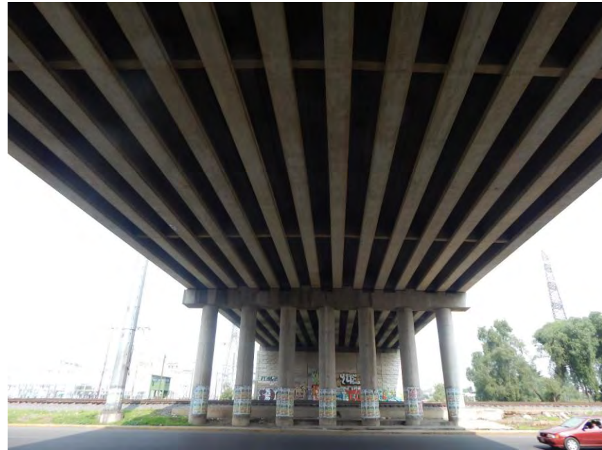
Fig. 210 Bajo puente en autopista Cuautitlán - Tlalnepantla
