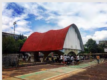
Fig. 10 y 11 Pabellón de Rayos Cósmicos C.U. 2017
