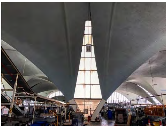
Fig. 141 Vista exterior y vistas interiores del edificio de embotellado 2019
