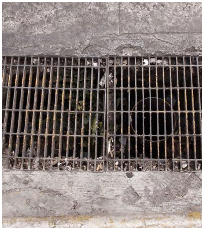
fig. 20 Sumidero utilizado como alcantarilla. ▶
