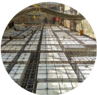
Este tipo de losas se elabora a base de un sistema de entramado de traveses cruzados que forman una retícula, dejando huecos intermedios que pueden ser ocupados permanentemente por bloques. Son los más usados actualmente, tienen dimensiones variables y se utilizan en el relleno de losas. Este tipo de losa necesita de un soporte (capitel) que se apoyara sobre la columna, este no debe exceder de  $1/6$  de la longitud de la luz entre columnas.
