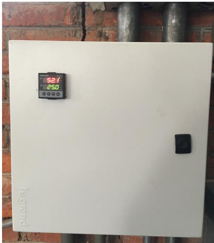
Fig. 12 PLC conectado al sensor de temperatura y extractor de aire
