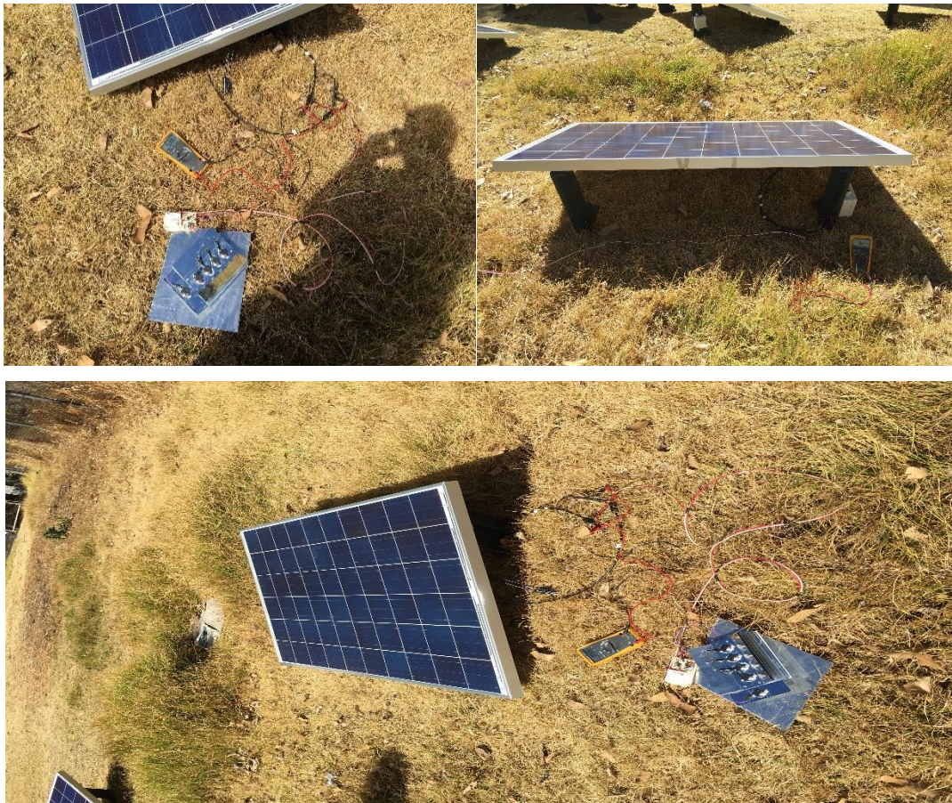
Fig. 53 Realización de pruebas a paneles fotovoltaicos
