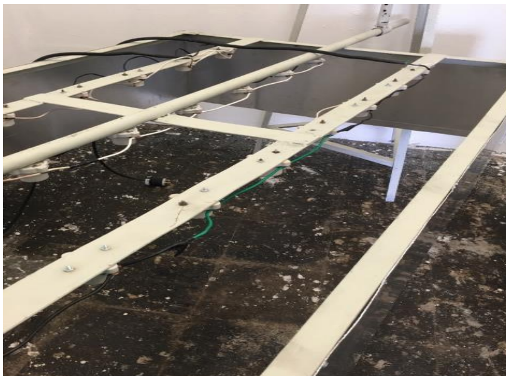
Fig. 7 Montaje de la estructura con concentrador solar
