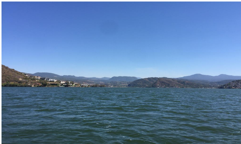
Figura 4. Vista de la Presa Valle de Bravo
