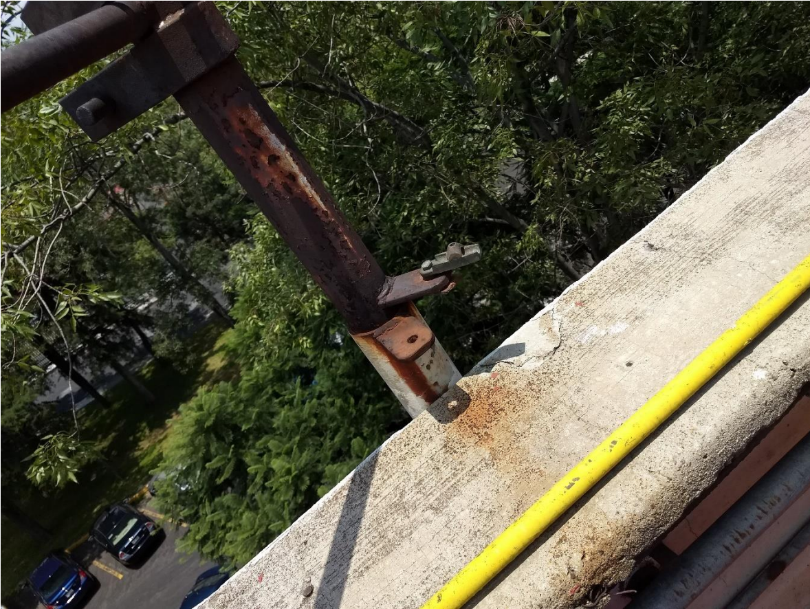
Figura 67 Evidencia de que esta grúa estuvo algún tiempo Interconectada al sistema de pararrayos, funcionando como punta interceptora del SPCDEA.
