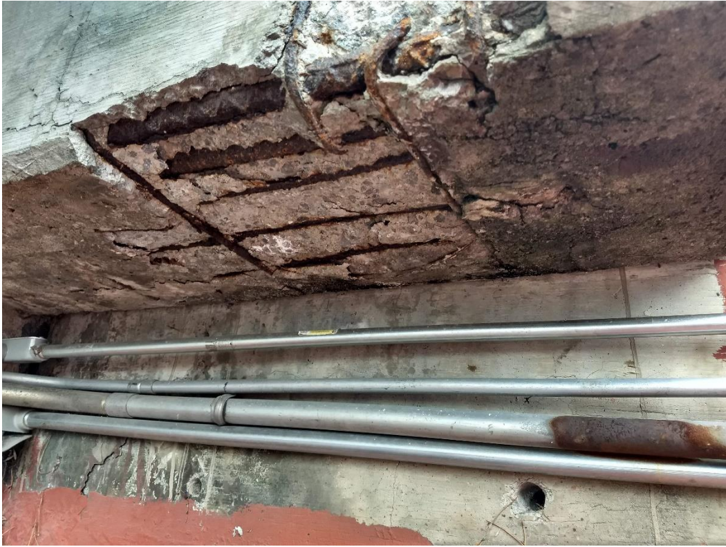
Figura 51 Ejemplo de falta de mantenimiento en el SPCDEE (tubo con muestras de corrosión).
