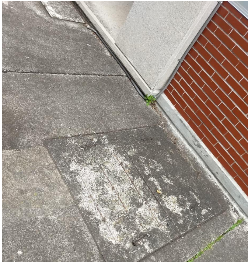
Figura 52 Evidencia de la existencia de la red de puesta a tierra del SPCDEE.
