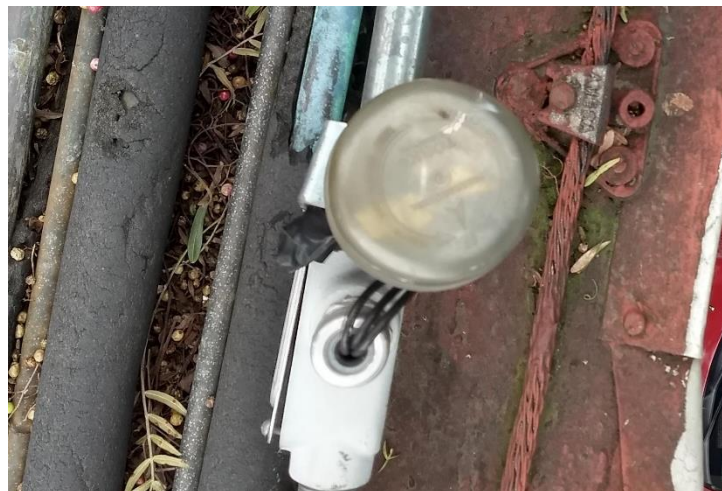
Figura 50 Ejemplo de inicio de cumplimiento con la NOM-022-STPS-2008, ya es imposible visualizar la información que reporta el medidor de resistividad conectado al SPCDEE.
