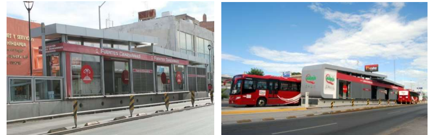
Imagen 4. Izq. Estación "Fuentes Danzarinas" al interior del centro histórico; Der. Estación Universidad, estación tipo en camellón.
