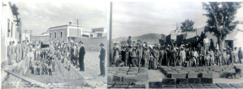
Imagen 16. Izq. Canalización arroyo "La Manteca" 1933; Der. Apertura de calle 13ª, mediados del siglo XX. Fuente: Archivo Histórico del Ayuntamiento.
