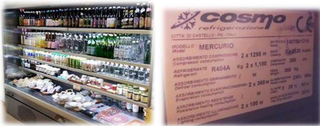
Ilustración 25. Placa de datos de Vitrina de refrigeración horizontal
