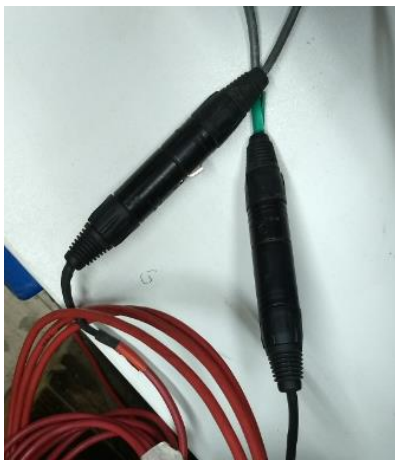
Figura 5.2.22 Cables de conexión entre la bobina del sensor y el cable de conexión con el convertidor analógico
