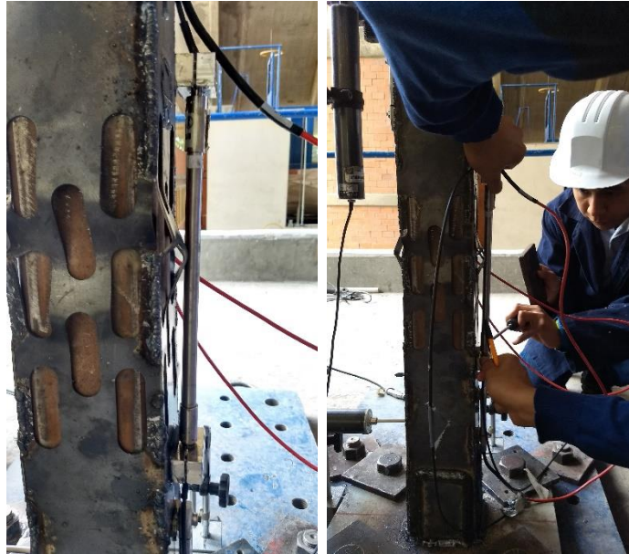
Figura 5.5.30 Momento en el que el SFO tuvo que ser retirado por el contacto con los elementos deformados del disipador
