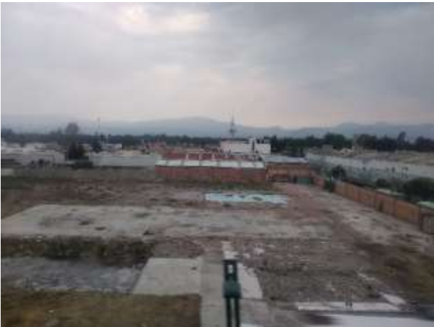
Fotografía 2. Baldío Urbano en el tramo Calle Once.
