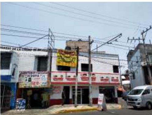
Fotografía 6. Habitacional con comercio en planta baja en el tramo Culhuacán.
