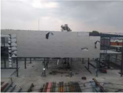
Fotografía 3. Construcción de un “Tláhuac Center” en el tramo Calle Once.
