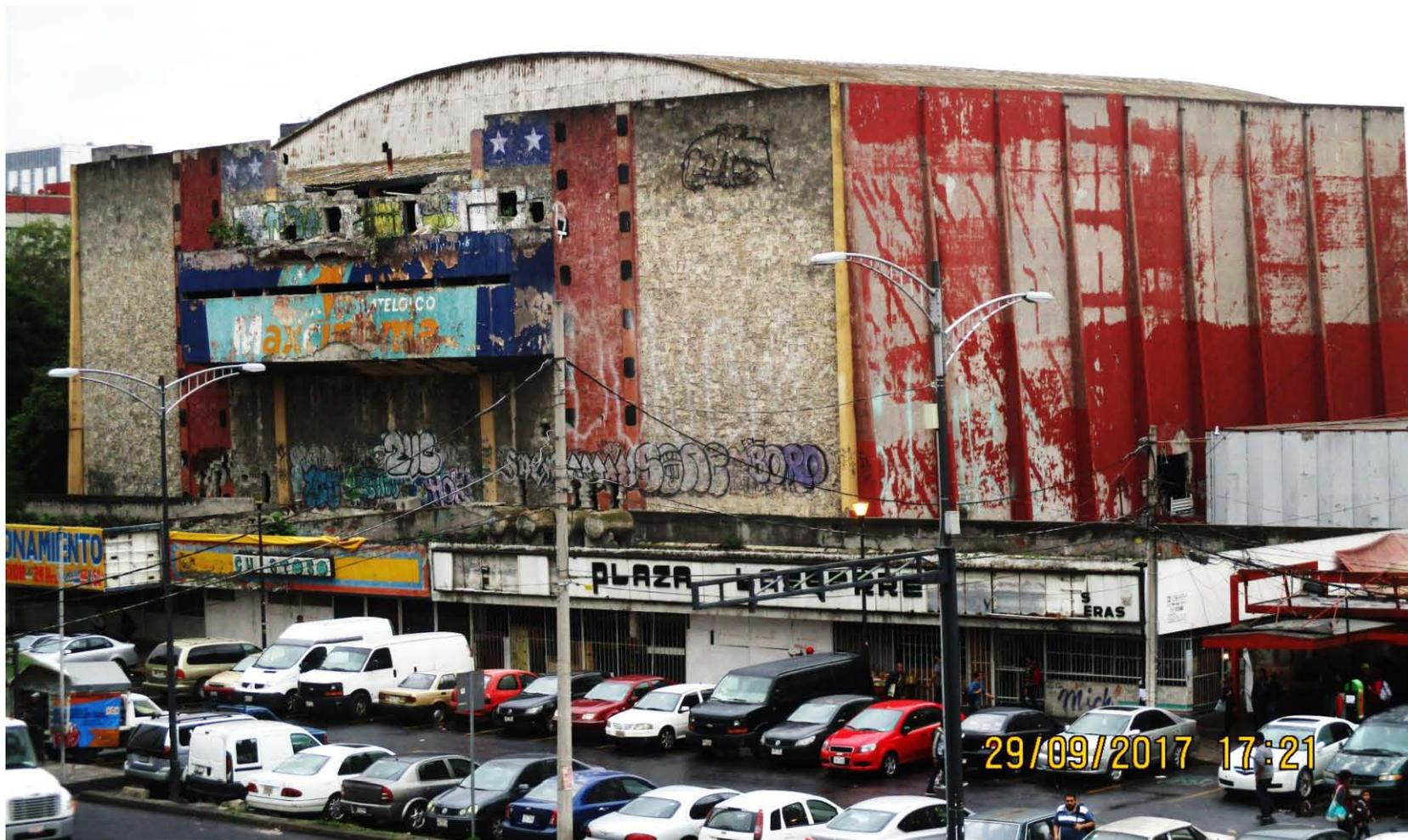
**FIG. 1.** Fotografía de la fachada principal del Cine Tlatelolco en una vista desde la Av. Manuel González (Eje 2 Nte) en su estado al día 29 de septiembre de 2017. Puede observarse un edificio completamente en abandono en sus dos cuerpos que lo conforman. El último de los daños que experimentó fue el del desprendimiento de una sección central alta de la fachada principal, esto a causa del sismo del 19 de septiembre del mismo año. Fuente: fotografía del autor.
