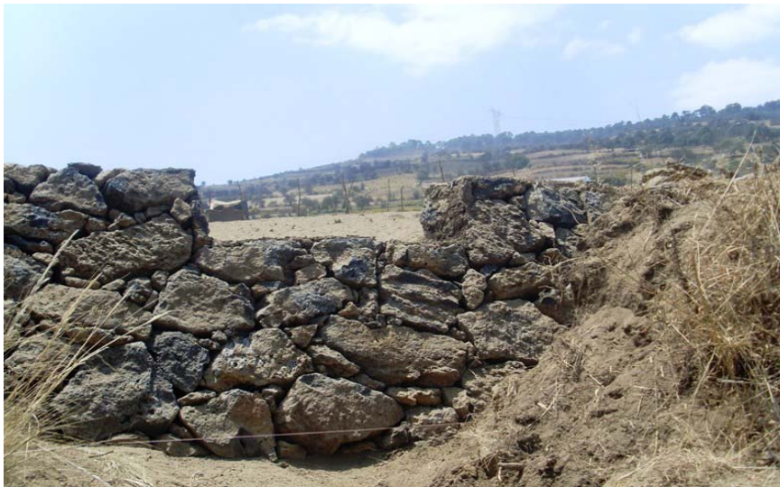
Fig. 17 Presa filtrante de piedra acomodada.
