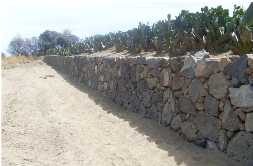
Fig.18 Muro filtrante de piedra acomodada.
