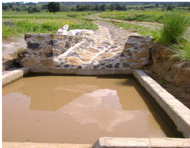
Fig. 20 Zampeado de cuneta.
