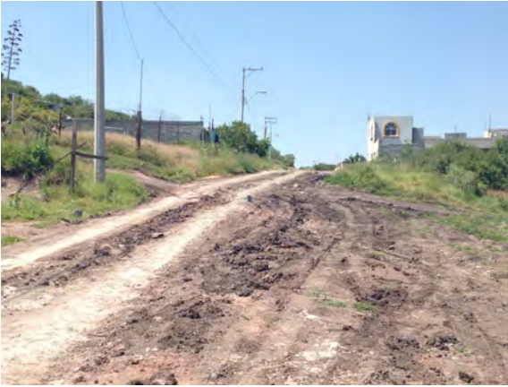
Imagen 18: Estado de las vialidades . Fuente: Elaboración propia.
