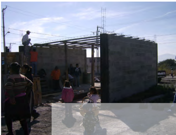
Imagen 30: Construcción del salón de usos múltiples en 2010. Fuente: Elaboración propia.
