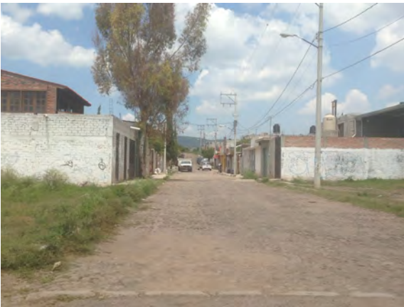
Imagen 26: Estado de las vialidades. Fuente: Elaboración propia.
