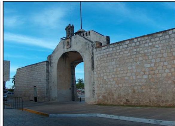
225. Puerta de Mar en la Muralla de San Francisco, Campeche
