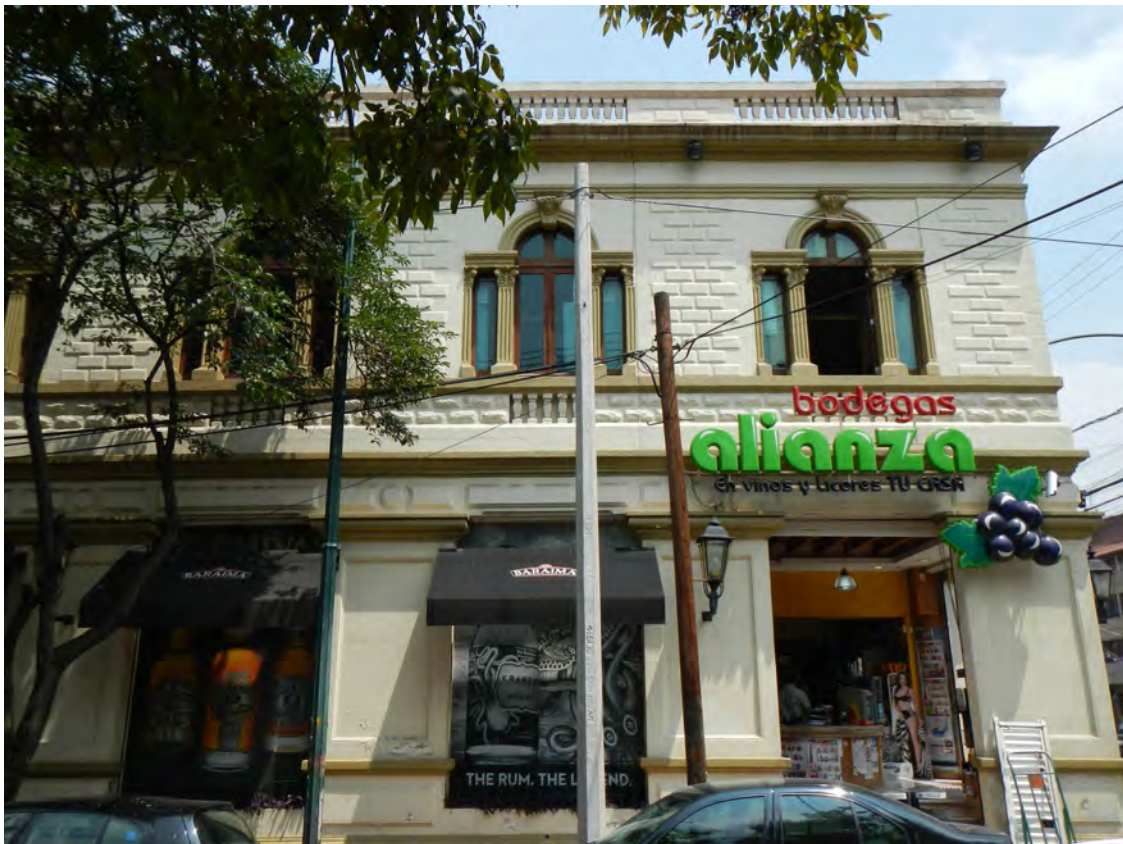
Figura 62: Residencia (actual comercio) en General Gómez Pedraza esquina General Pedro Antonio de los Santos . Las intervenciones son visualmente invasivas imposibilitando parcialmente la lectura correcta del edificio patrimonial. Fotografía: Aura Mondragón Moreno. Fecha: septiembre 2018.
