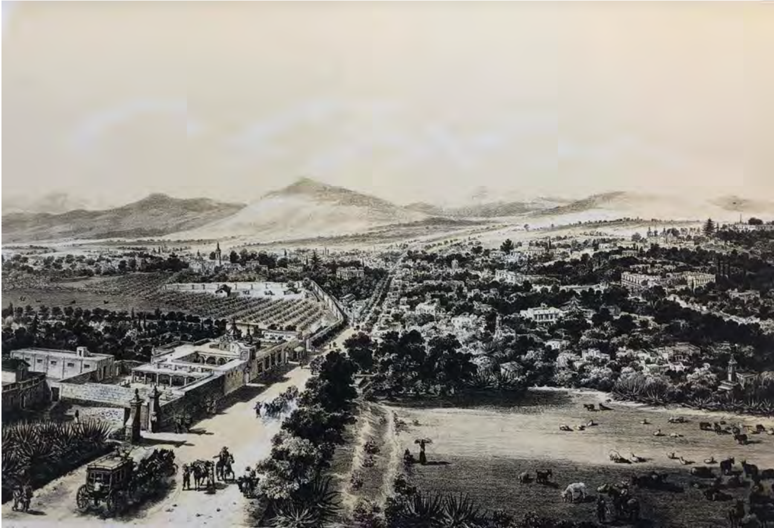
Figura 9: La Hacienda de la Condesa en 1850 . Fuente: Antonio Fernández Del Castillo, Tacubaya. Historia, leyendas y personajes (México: Porrúa, 1991), p.306.
