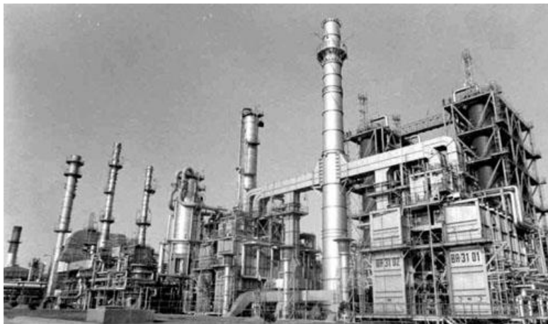
Ilustración 27: Detalle de las instalaciones de la Refinería Miguel Hidalgo, inaugurada en Tula, Hidalgo, México en 1977, con capacidad combinada de 150,000 barriles diarios. Recuperado de http://mexicomaxico.org/Voto/pemex.htm ,
