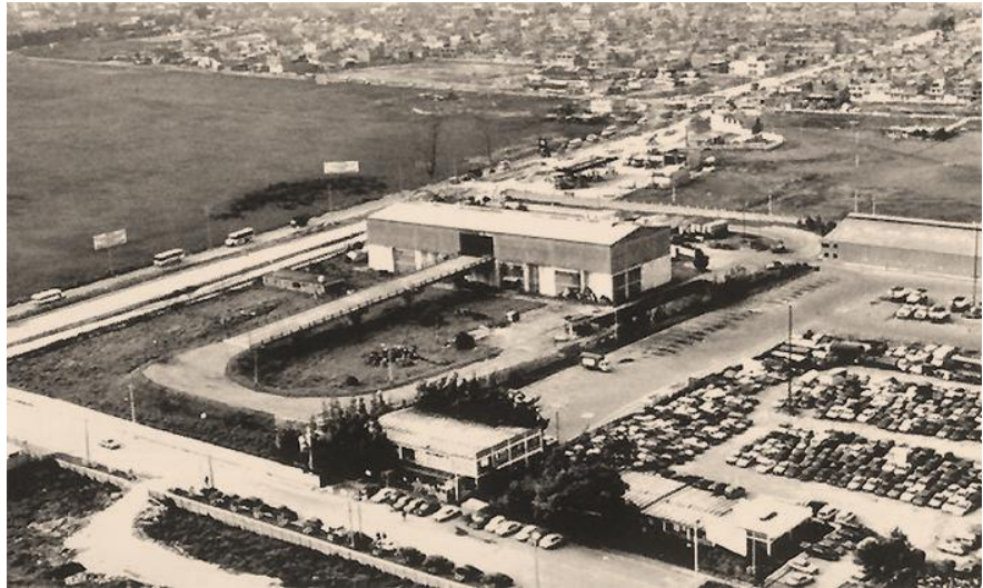
Ilustración 16: Antigua planta de tratamiento de basuras, en desuso a partir de 1993. (EDIS) Bogotá, Colombia. 29
