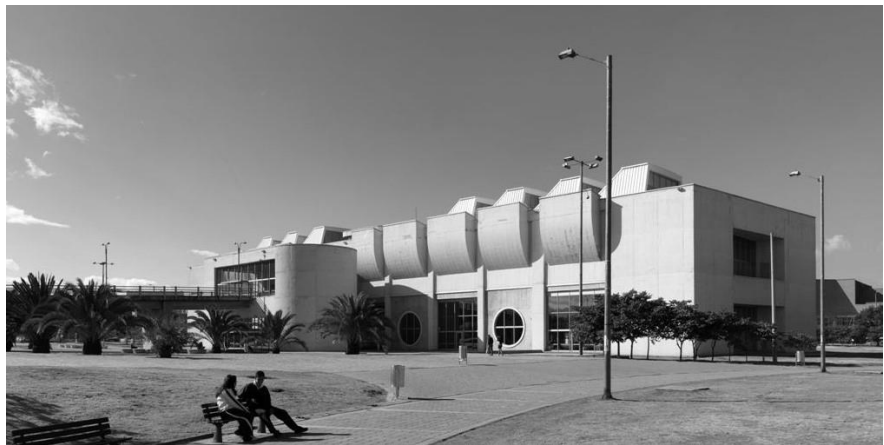
Ilustración 17: Biblioteca Pública “El Tintal” 1998-2002 por Arq. Daniel Bermúdez. Se diseña como biblioteca en el edificio de la antigua planta de tratamiento de basuras que contaba con bodega, puente para carros de recolección y parqueadero. Bogotá, Colombia. 30
