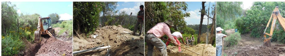
Figura 28. Instalación de tubería, excavación de zanjas.
