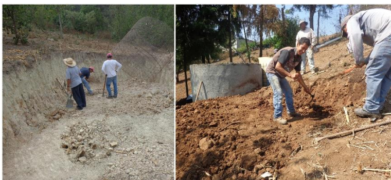
Figura 22. Fotos de preparación del terreno.
