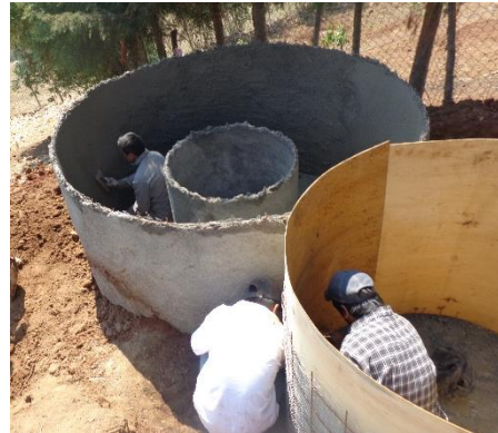
Figura 26. Fotos de repellado.
