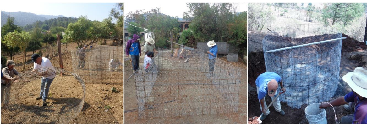
Figura 24. Fotos de montaje de la estructura.
