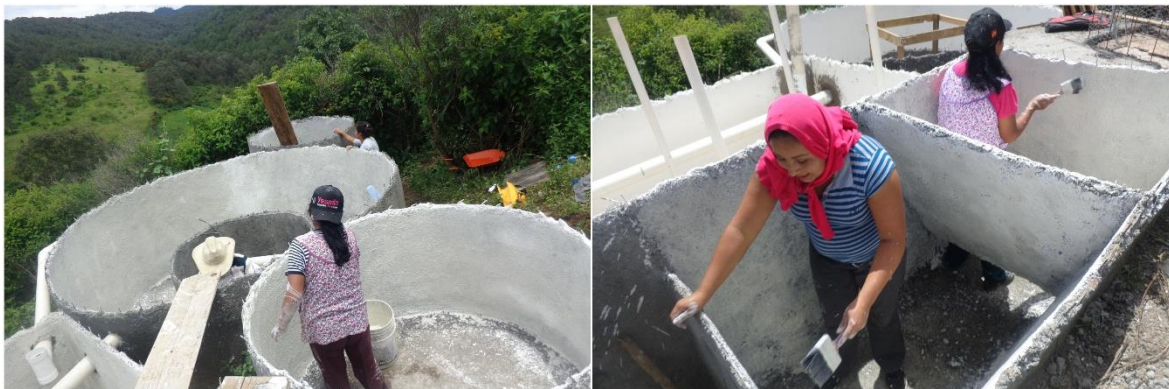
Figura 27. Impermeabilización de sistema 2.
