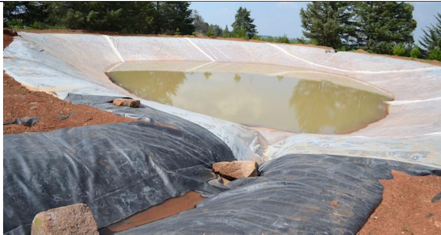
Fig. 6. Universidad Autónoma de Querétaro, implementación de sistema de captación de agua de lluvia
