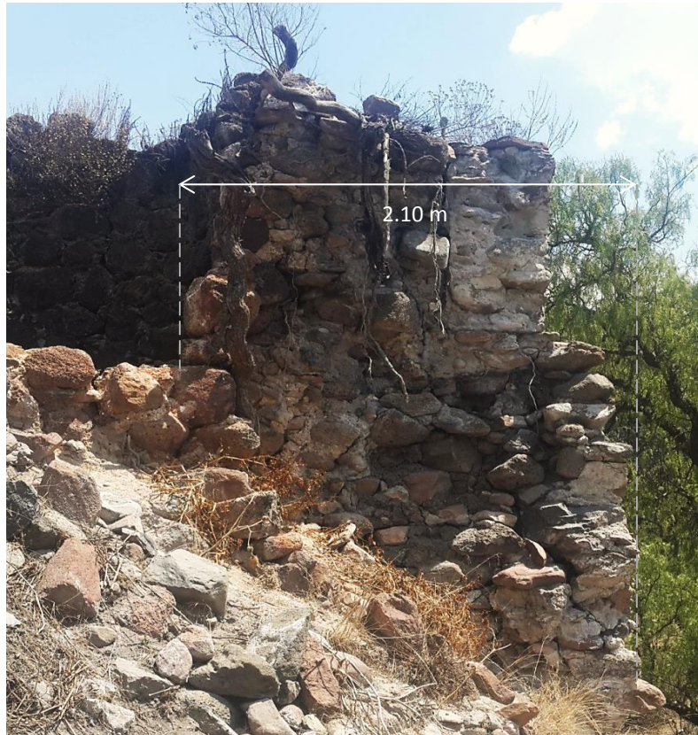
Imagen 114. Detalle de muro en el H-3. La ruina permite conocer y estudiar los procesos constructivos, las distintas capas de piedra determinan las etapas de los muros iniciando con la cámara y engrosándolo hasta llegar al talud y escalonamiento en su etapa final. 2017.
