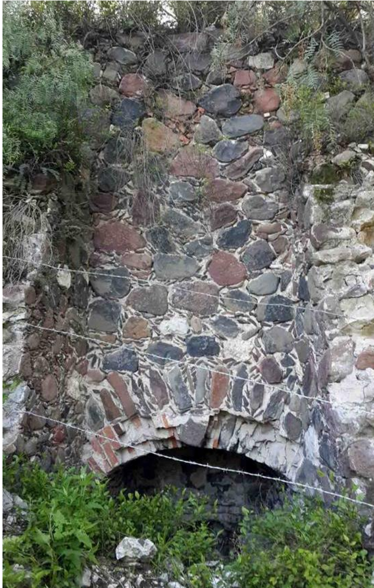
Imagen 98. Vista frontal de la boca de alimentación, entre dos contrafuertes. 2018.
