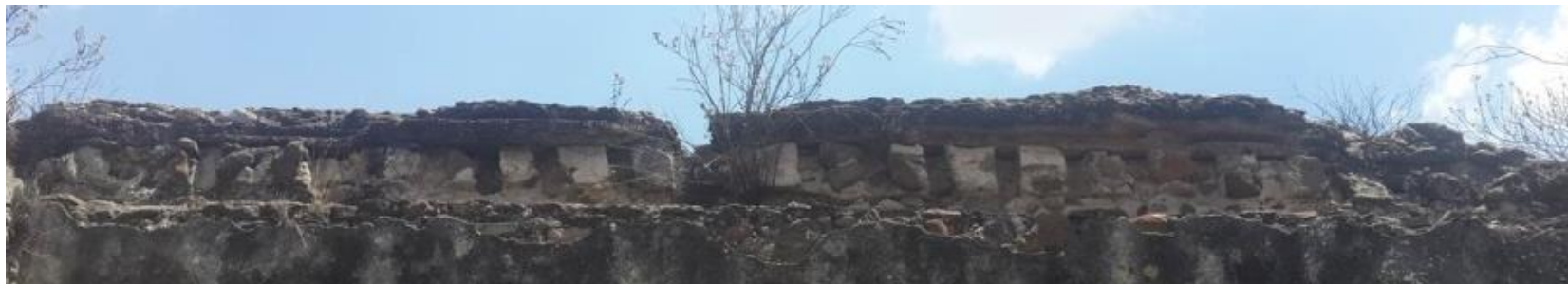
Imagen 80. Detalle de mechinales en el muro colindante sur del casco principal. 2017.
