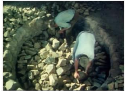
Imagen 119. Secuencia de preparación de piedra caliza en la cámara del horno, sin aglutinantes iniciaba la formación de la falsa bóveda perfectamente armada para recibir todo el peso de la demás piedra y dejar el espacio donde se prepararía el fogón para iniciar el calcinado. Tomado de Gransdorf & Eifel, (1979).
