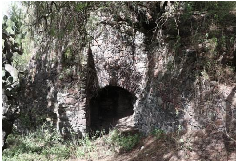
Imagen 104. Vista general del la camara de extraccion. 2019.
