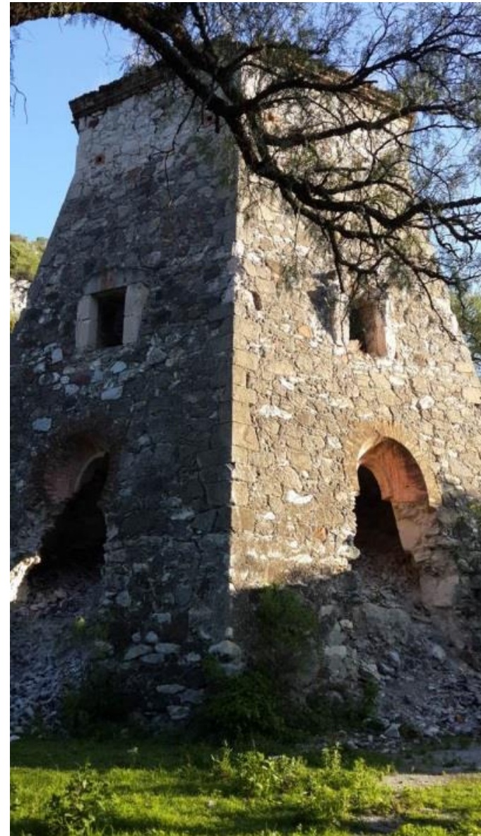
Imagen 146. Vista general fachada sur oriente del horno Rumford de la Hacienda Calera de Apaxco. Interior completamente colapsado.
