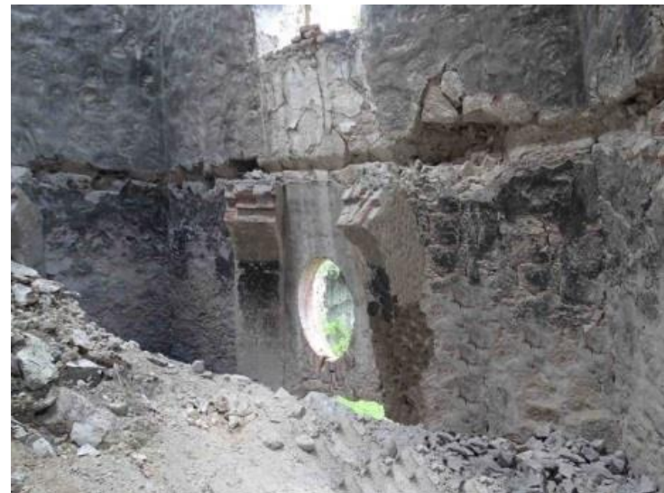
Imagen 159. Interior de horno Rumford de Apaxco, vestigios del arranque de los arcos y nivel de entrepiso, en la parte superior las adarajas unían los muros a la cámara, un óculo marca el dimensionamiento de la cámara de calcinación, sus restos yacen en un montículo de piedras.
