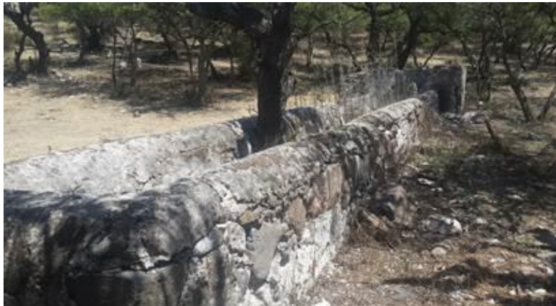
Imagen 48. Vista general de un abrevadero ubicado a 50m al sur del casco principal. Los muros bajos están coronados con un boledo enfoscado. 2017.
