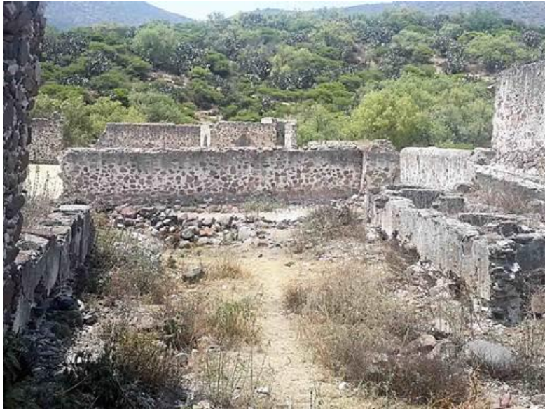
Imagen 72. ⑦. Vista general de lavaderos, al fondo plaza de acceso. 2017.
