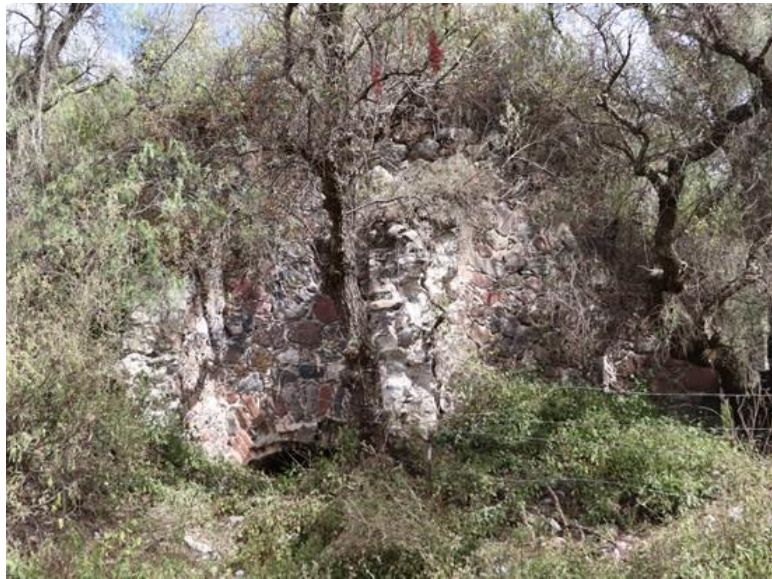
Imagen 96. Estado actual, vista general lado poniente del Horno Tradicional. Pérdida de mamposteo en los contrafuertes, en la parte baja se aprecia la boca de alimentación. 2019.
