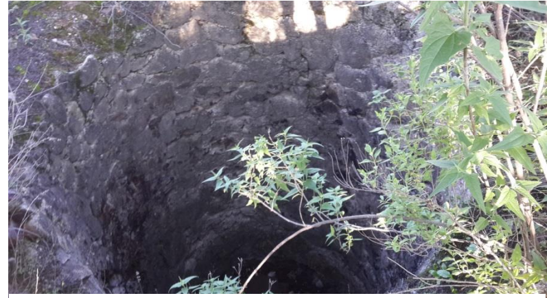
Imagen 101. Vista de la cámara del H-2 a pie de tiro. 2018.
