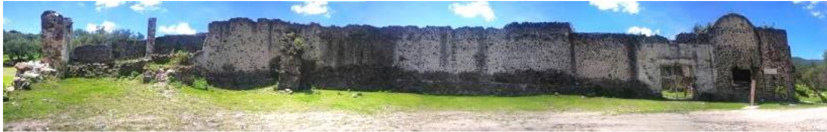
Imagen 61. Estado actual, fachada norte del casco principal de la Hacienda Calera de Apaxco, 2018.
