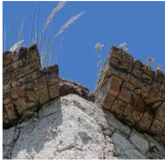
Imagen 158. Detalle de cornisa.
