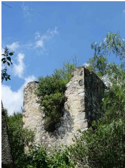
Imagen 154. Estado actual del apoyo para el puente, conexión entre el banco de material y el horno.
