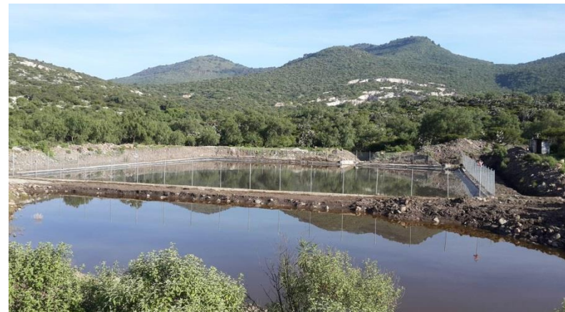
Imagen 42. Jagüey. Vista hacia el poniente, al fondo se ven las tolvas de extracción de piedra caliza. 2018.
