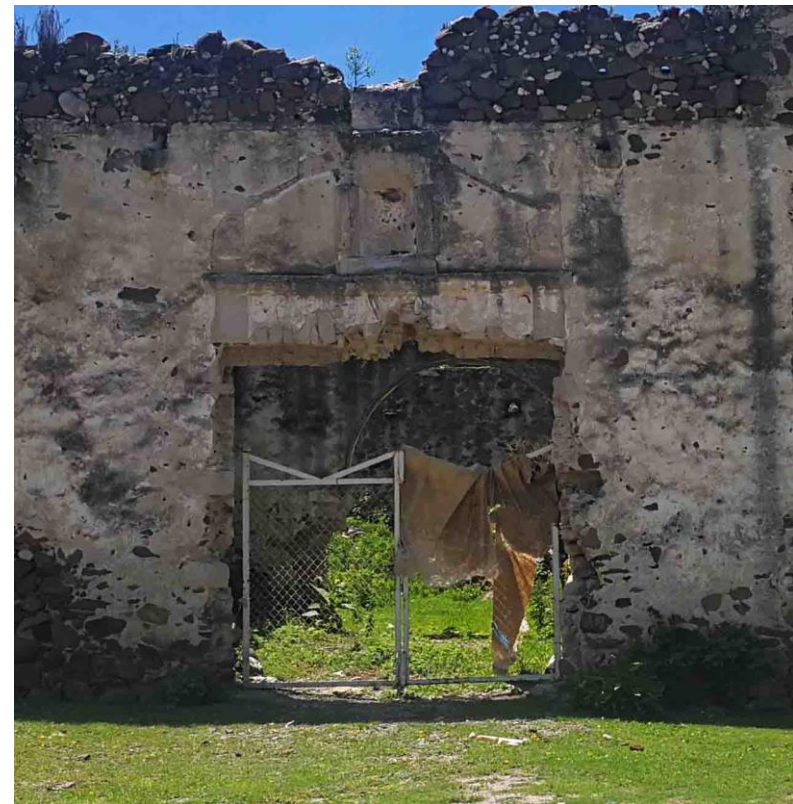
Imagen 74. Estado actual, vista de la portada del acceso al casco. 2018.
