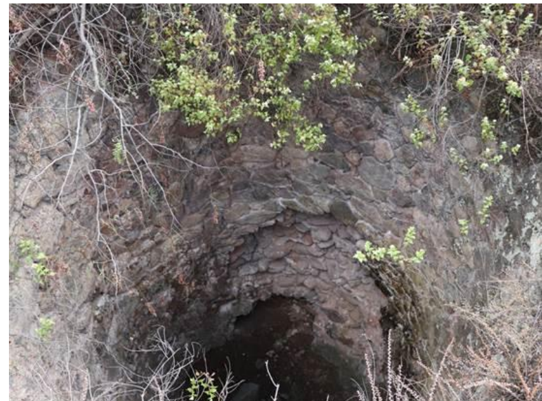
Imagen 97. Vista de la cámara del H-1 a pie de tiro. 2019.
