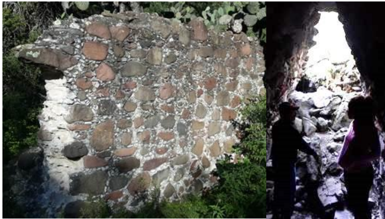
Imagen 44. Lado izquierdo, sección de muro del acueducto en ruinas. Lado derecho, estructura de arco falso del acueducto. 2018.
