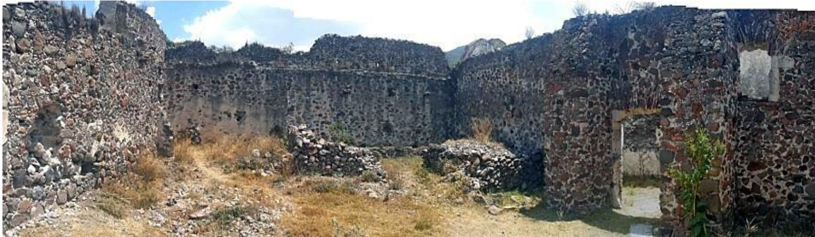
Imagen 64. ①. Vista general del patio de trabajo, al fondo la bodega y el taller, del lado derecho el acceso al almacén entre contrafuertes. 2017.
