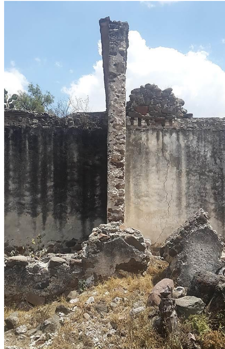
Imagen 70. ⑨. Detalle de muro agregado en dormitorios, espesor 25 cm. 2017.
