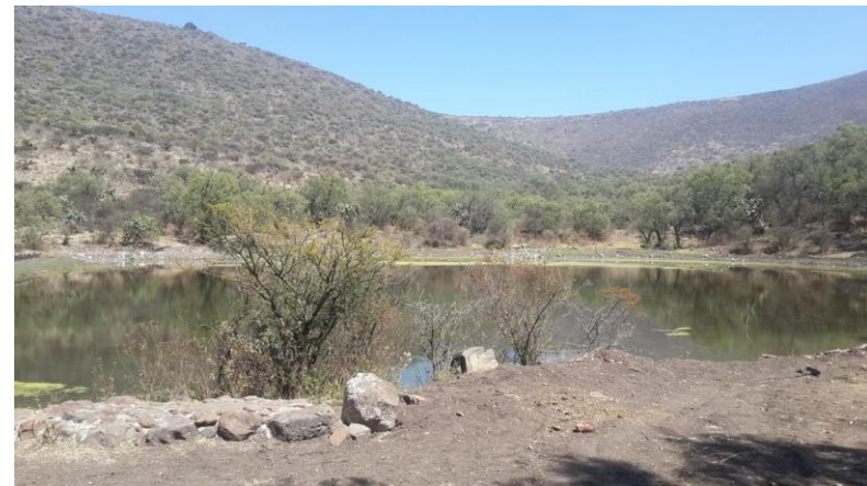
Imagen 39. Vista hacia el noreste de la Presa I. 2018.
