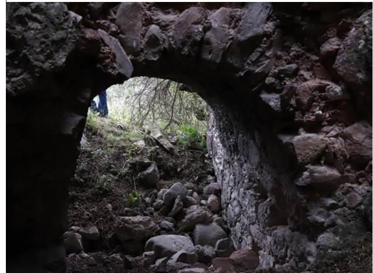
Imagen 99. Detalle boca de extracción, vista desde el interior del horno. 2019.
