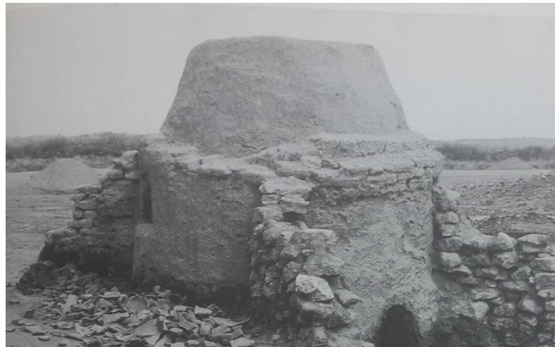
Imagen 92. Horno de piedra y arcilla, del lado derecho se encuentra el acceso a la cámara de calcinación, el segundo vano es la cámara de alimentación. Tomado de Pierre-Adam, Jean. 2002.
