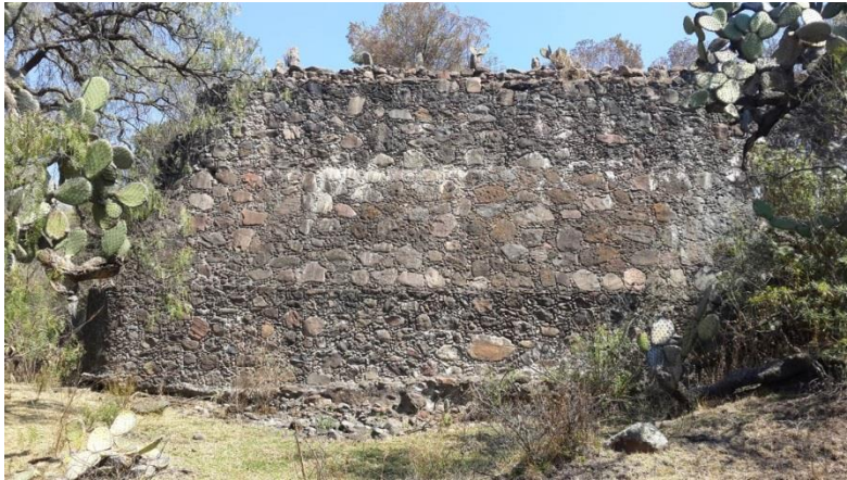
Imagen 41. Cortina de la Presa II. Vista de la fachada poniente. 2018.
