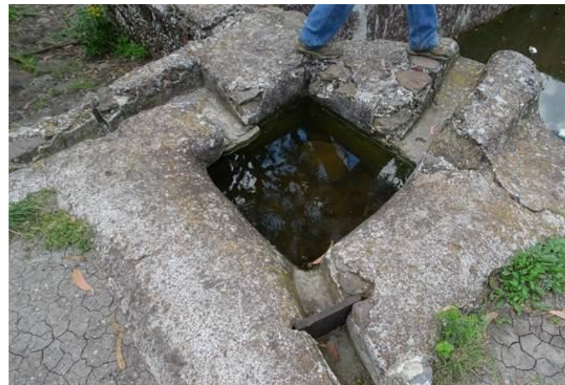
Imagen 45. Arriba 43a, estado actual, vista general al sur del aljibe. Abajo 43b, filtro y atarjeas con enlucidos, y esclusas. 2018.
