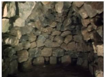
Imagen 119. Secuencia de preparación de piedra caliza en la cámara del horno, sin aglutinantes iniciaba la formación de la falsa bóveda perfectamente armada para recibir todo el peso de la demás piedra y dejar el espacio donde se prepararía el fogón para iniciar el calcinado. Tomado de Gransdorf & Eifel, (1979).
