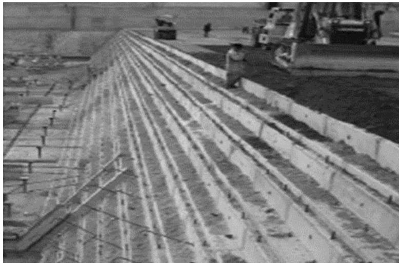
*Figura 1.9 Tamaño de capas y colocación de prefabricados en la cara aguas abajo (Guillemot & Lino, 2012).*
