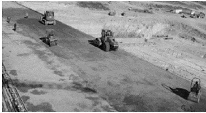
Figura 1.6 Compactación de la capa de hardfill con rodillo vibratorio (i.e. Guillemot et al., 2012).
