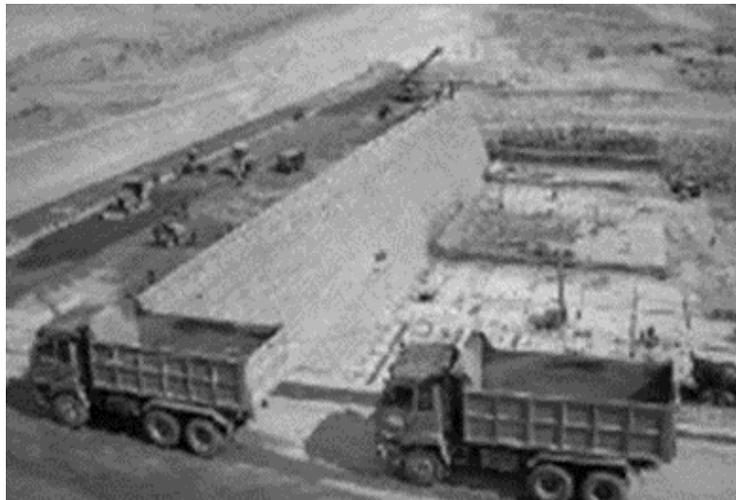
Figura 1.5 Acarreo de la mezcla de hardfill con camiones de volteo (i.e. Guillemot et al., 2012)
