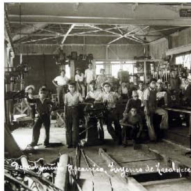
2 Trabajadores del "departamento mecánico" (en el ingenio de Zacatepec.
