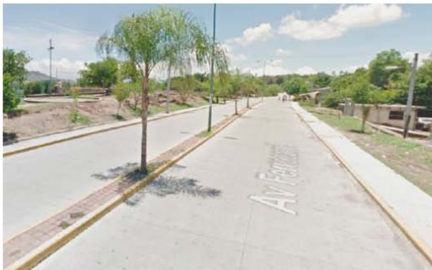
13 Vista del estado actual de la avenida.
