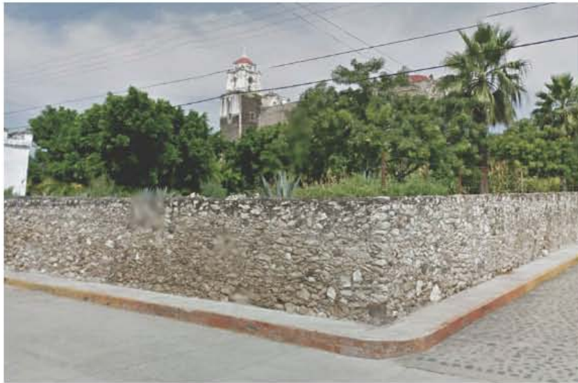
21 Vista actual del terreno baldío.
