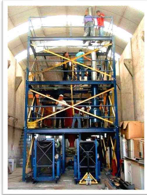
Figura 1.4 Gasificador del Instituto de Ingeniería de la UNAM (Barrera, 2008).
