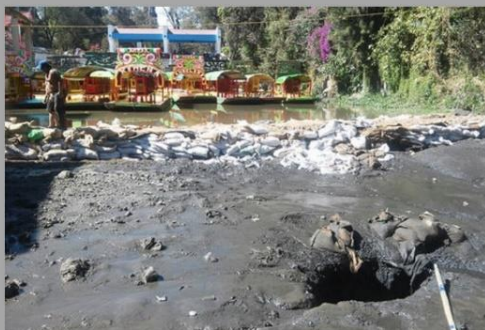
Imagen No. 38. Desección de canales de Nativitas Zacapa a causa de la fractura del lecho.
