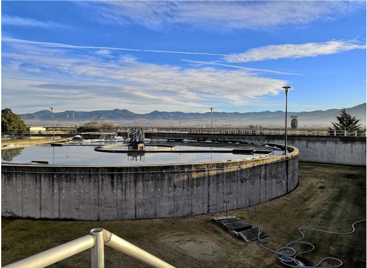
Figura 11. Área de clarificadores. Creación propia.
