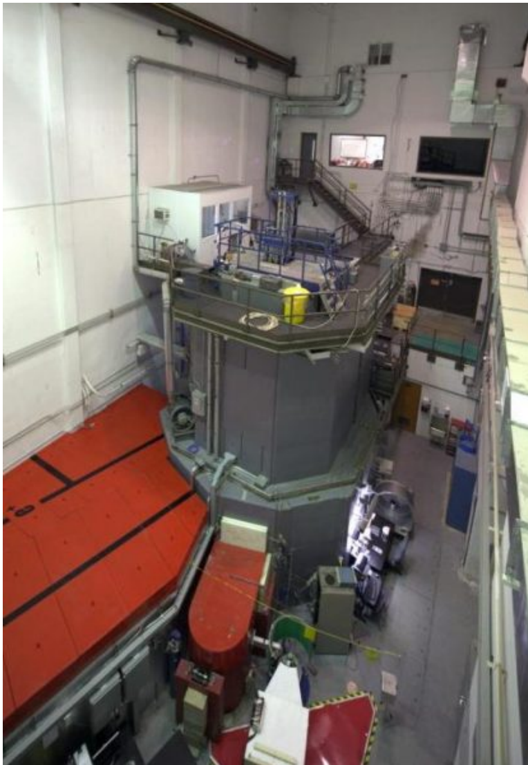
Figura 4.1: Instalaciones del reactor PULSTAR (18).
