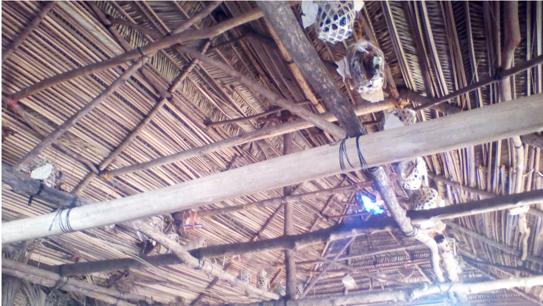
Fotografía 10. Techo del dabuyaba y canastas ( guagai ) colgando. Foto del autor.
