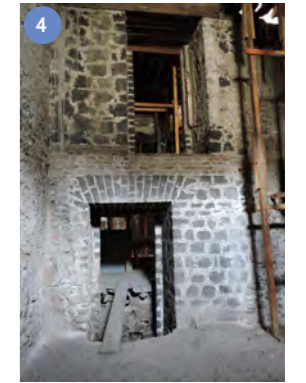
4 Vista interior del local sur-oeste
