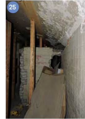
Vista norte-sur del interior del local este desde las escaleras actuales
