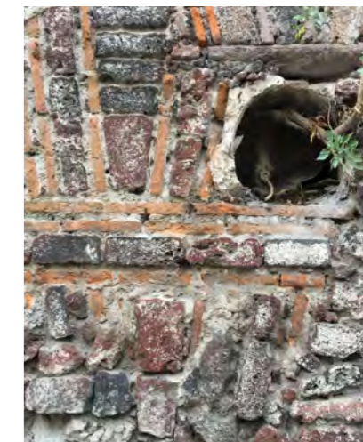
Figuras 47, 48 y 49. Víctor Sandoval. Fotografías de estado actual en fachada del edificio en la fachada de Corregidora y Jesús María, 2018. Los daños más evidentes son causados por los hundimientos diferenciales en el suelo y el graffiti sobre rocas y láminas
