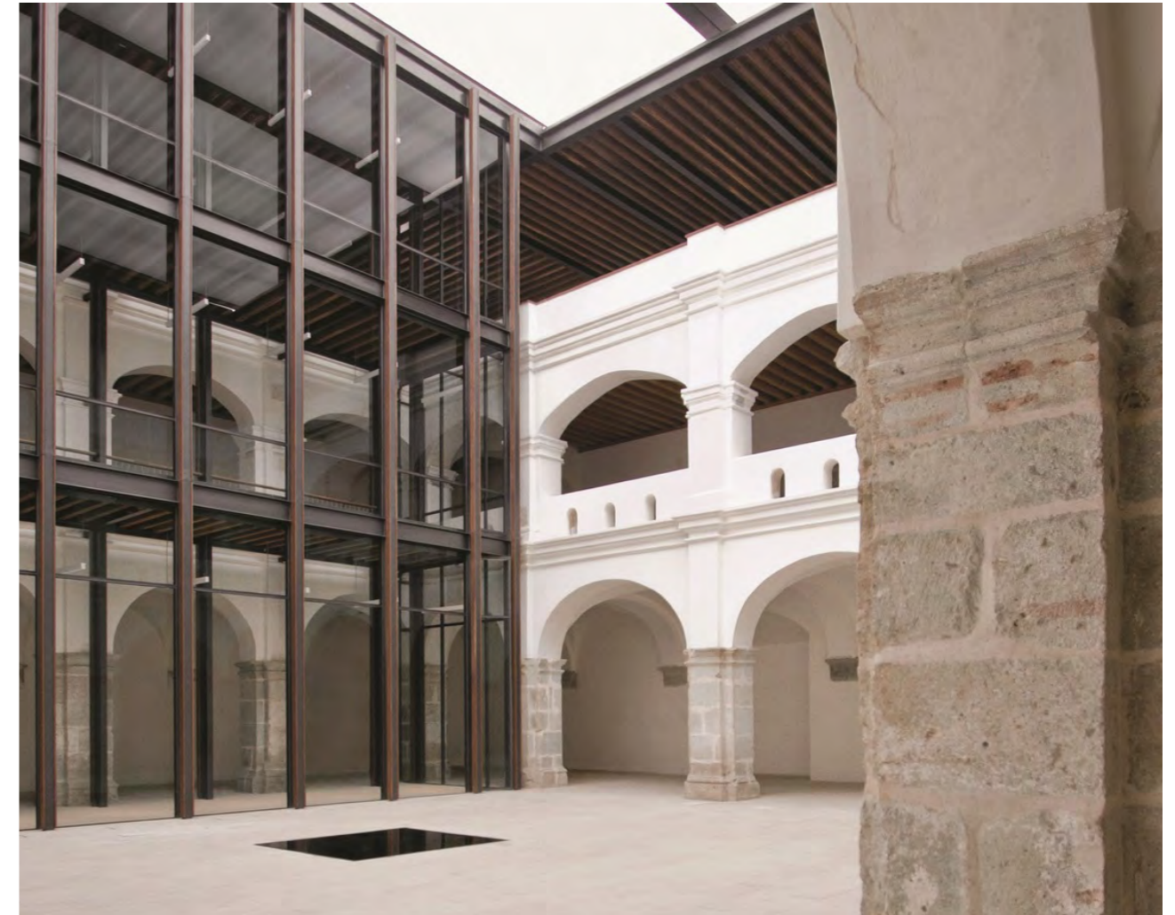
Figura 71. Vista de patio interior.
