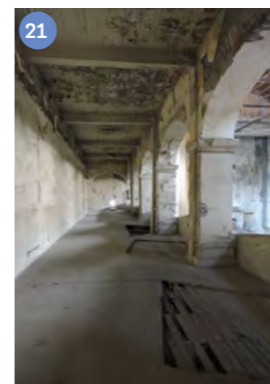
Galería poniente. Vista hacia el norte mostrando la clausura interior
