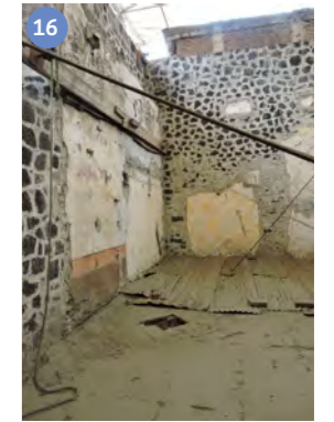
Tensores al extremo poniente del local sur
