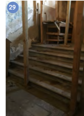
Galería oriente. Vista hacia el sur con apuntalamiento
