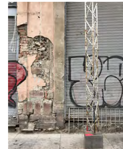
Figuras 44, 45 y 46. Víctor Sandoval. Fotografías de estado actual en fachada del edificio en la fachada de Corregidora y Jesús María, 2018. En éstas fotografías se pueden observar las afectaciones en los acabados de la fachada, y de igual forma, la basura acumulada por comerciantes a lo largo de la calle.
