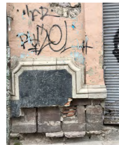
Figuras 47, 48 y 49. Víctor Sandoval. Fotografías de estado actual en fachada del edificio en la fachada de Corregidora y Jesús María, 2018. Los daños más evidentes son causados por los hundimientos diferenciales en el suelo y el graffiti sobre rocas y láminas
