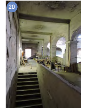
Galería oriente. Vista hacia el sur desde la escalera
