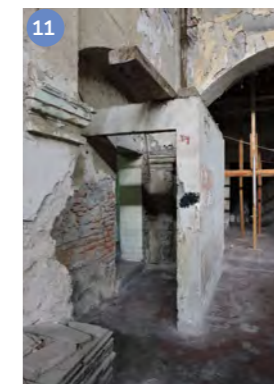
11 Vista de la modificación exterior para el acceso a sanitarios
