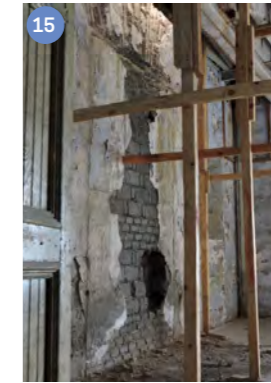
Muro clausurado en el sur-este del edificio
