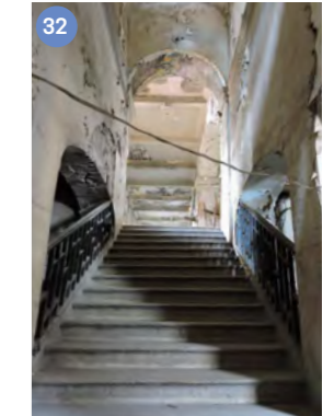
Galería oriente. Vista hacia el sur desde la escalera
