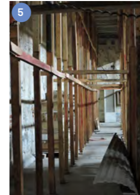
5 Galería poniente. Vista hacia el norte
