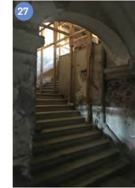
Muro clausurado en el sur-este del edificio
