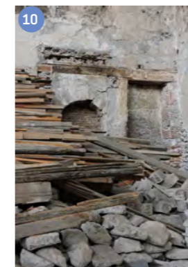
10 Vista del vanos tapiados al fondo del antiguo escenario con material
