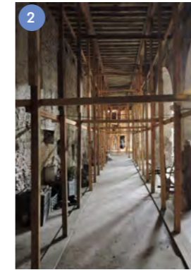
2 Galería sur. Vista hacia el poniente mostrando el apuntalamiento de refuerzo
