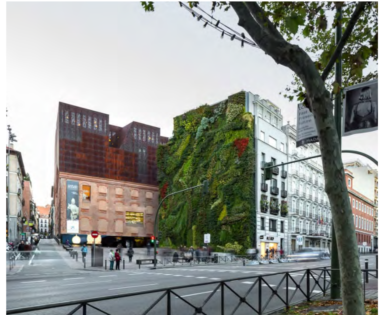
Figura 7. Simón García, Fotografía del Caixa Forum desde el camellón de Paseo del Prado. Recuperado de: Divisare.com ( https://divisare.com/projects/370386-herzog-de-meuron-simon-garcia-arqfoto-caixa-forum-madrid )
