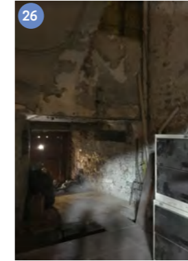
Vista de las escaleras conectando planta baja y primer nivel, ubicadas al este del inmueble
