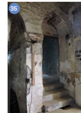
Vista desde un espacio en un muro tapiado hacia el exterior del complejo con edificio colindante
