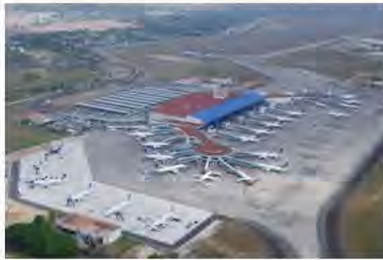
Imagen 48. Vista aérea de Aeropuerto Internacional Tocumen Panamá, se observa la infraestructura y tamaño del aeropuerto. Imagen recuperada en: http://www.aeropuertos.net/aeropuerto-internacional-de-tocumen/
