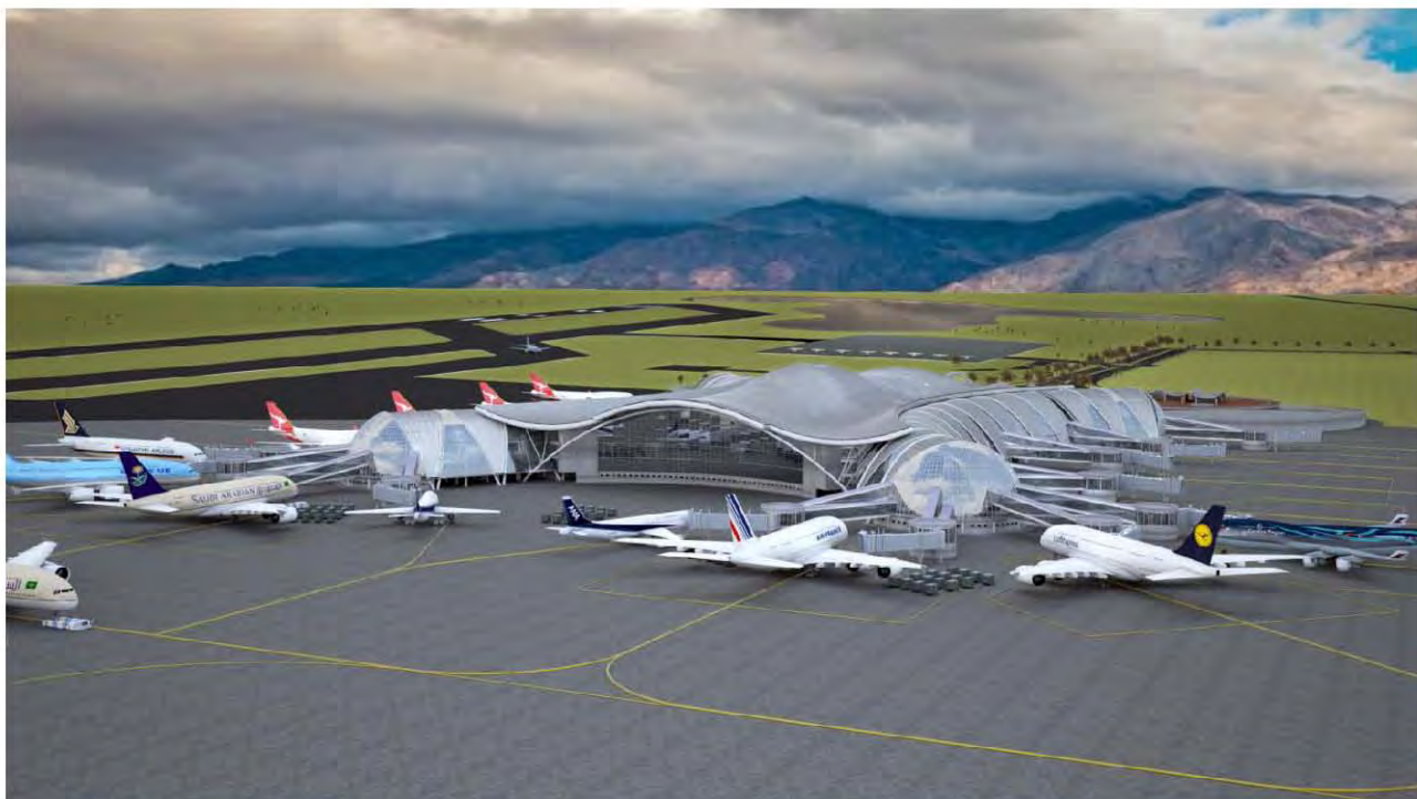
Vista de terminal y plataforma de operaciones
