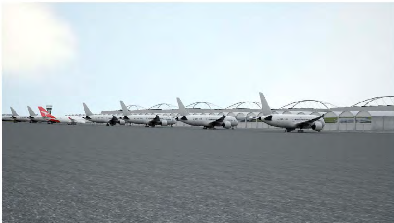
Vista plataforma de zona de carga
