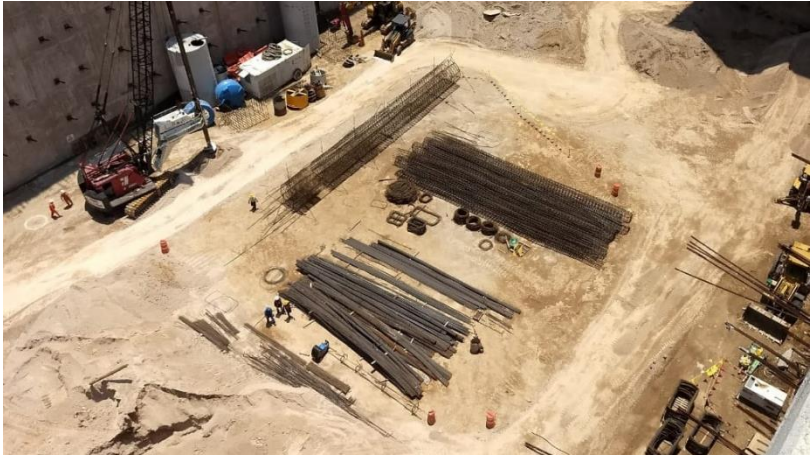
Figura 8: Almacenamiento de varilla y habilitados en obra
