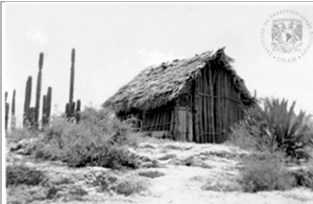
Figura 05 (Cap. 2): Ejemplo de vivienda construida con órganos.
