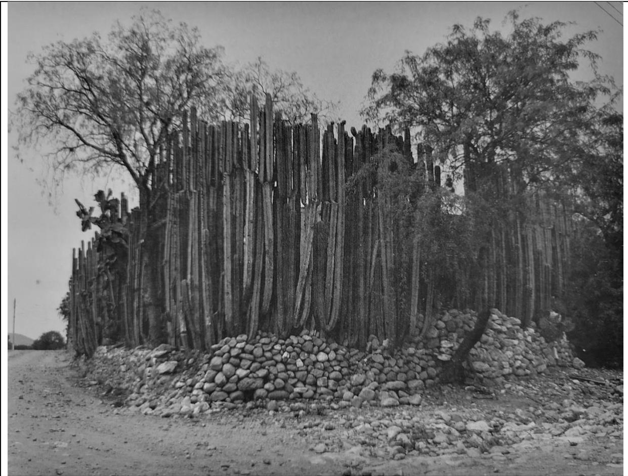
Figura 06 (Cap. 2): Ejemplo de barda perimetral construida por órganos.
