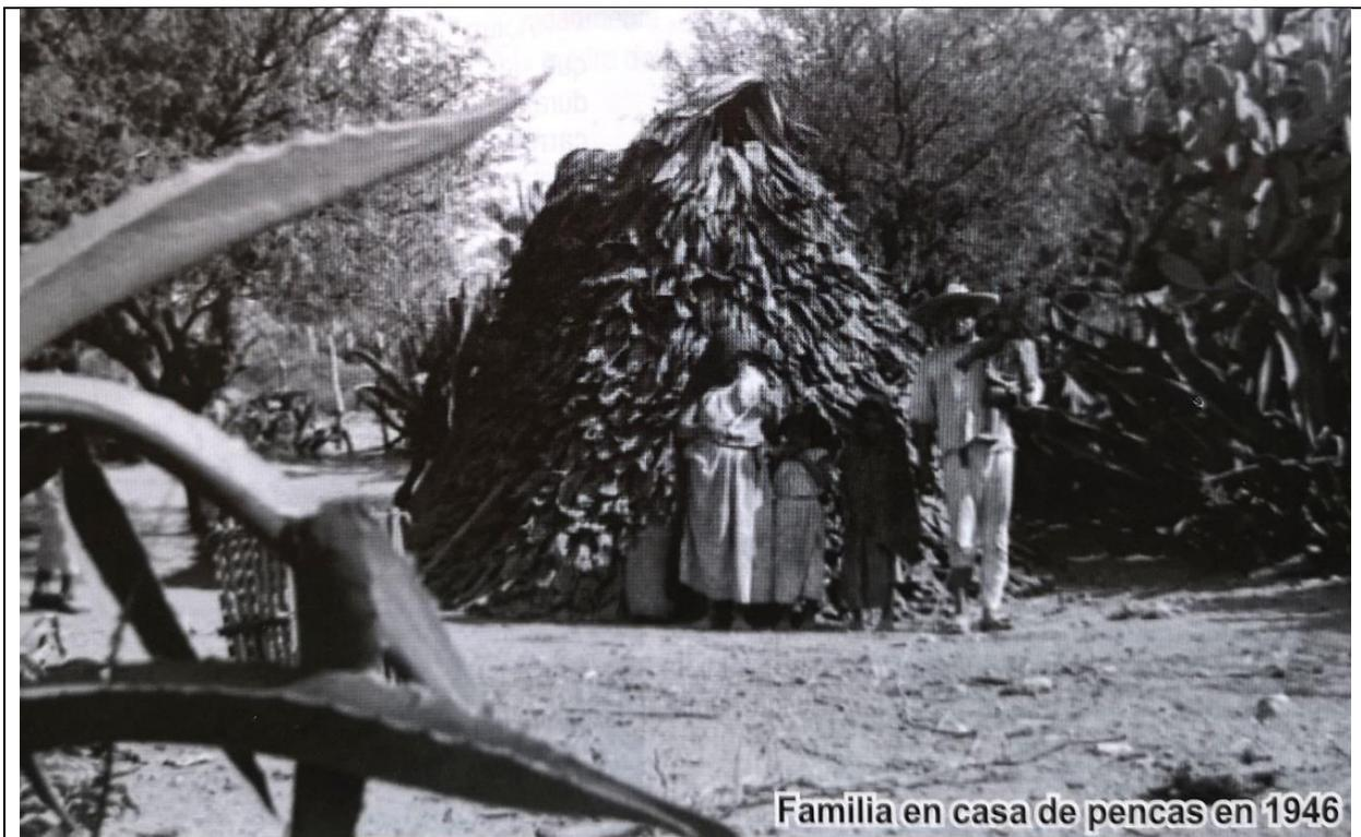
Figura 04 (Cap. 3): Vivienda realizada completamente por penca de maguey.
