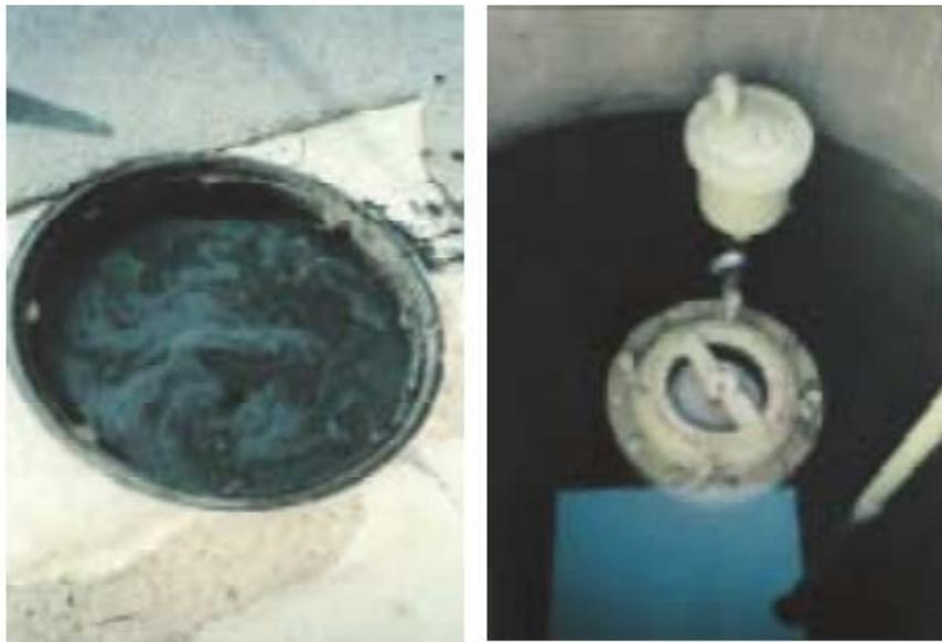
FIGURA 1.3-5 VÁLVULA DE ALIVIO SUMERGIDA
