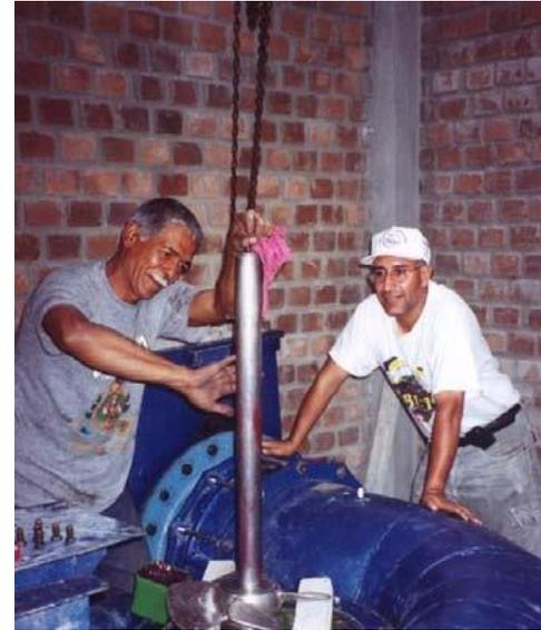
**Ilustración 17** Montaje de turbina axial de 25 kW, Las Juntas, Perú
