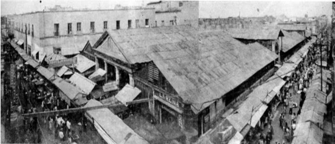
Fotografía 24. El antiguo mercado de La Merced fue construido con una estructura de hierro bajo el Porfiriato, ya estaba funcionando en 1880. Fuente: Portal académico CCH UNAM, s.f.
