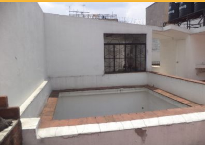
▲ Fotografía N 5 Azotea
