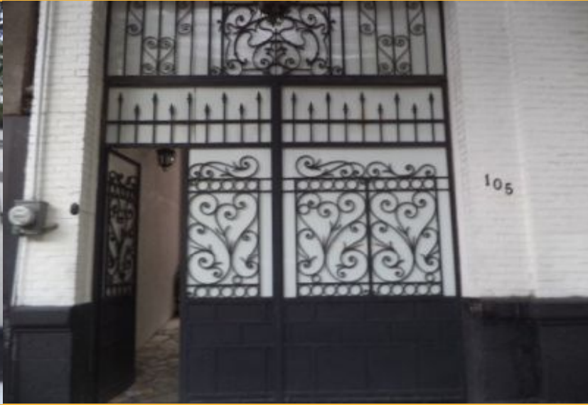
▲ Fotografía N 2 Portón de acceso.
