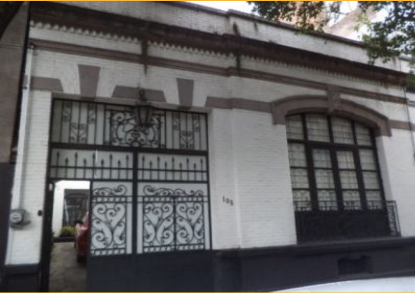
▲ Fotografía N 1 Fachada Principal
