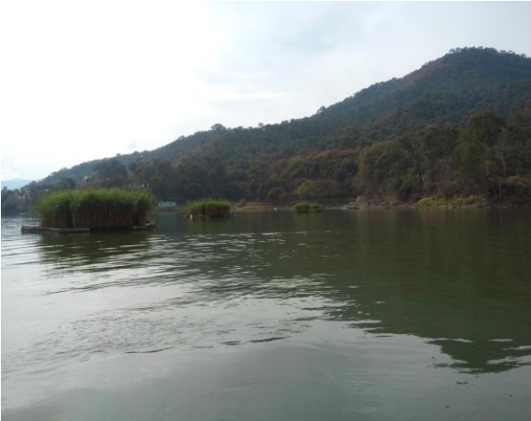
Figura A.2.1 Presa Valle de Bravo
