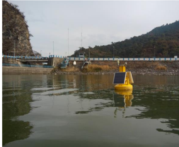
Figura A.2.2. Boya ubicada en la Presa Valle de Bravo
