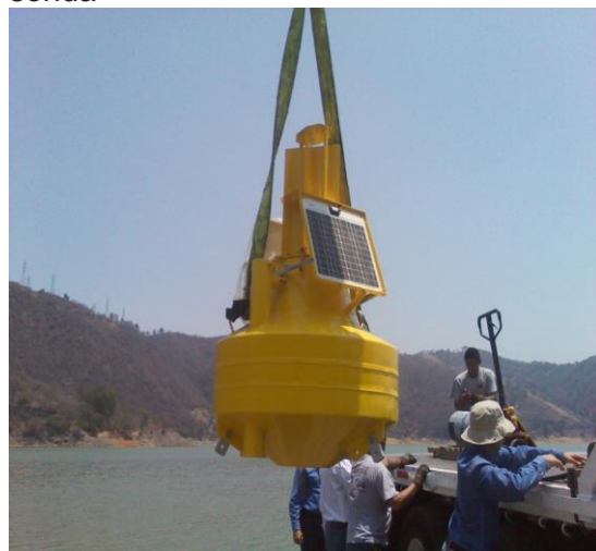
Figura A.2.12. Colocación de la Boya
