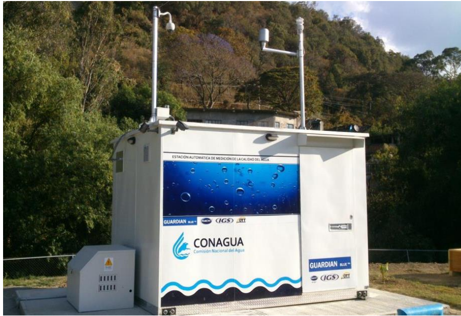
Figura 3.9. Guardian Blue : Exterior de la estación automática de medición de la calidad del agua (CONAGUA, 2013)
